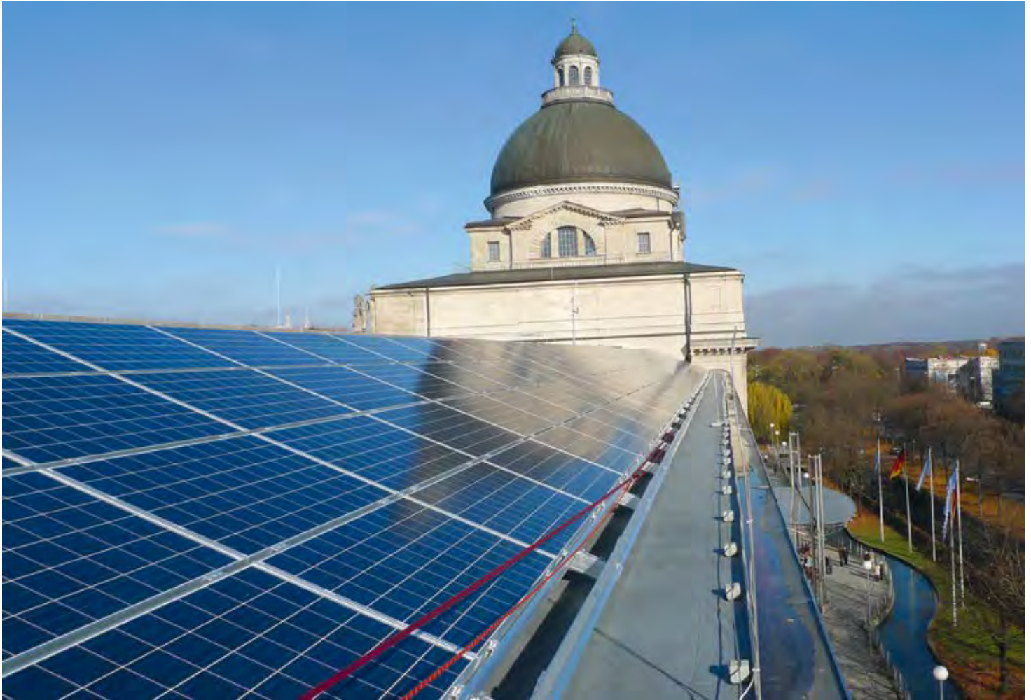
Die Solaranlage auf der Bayerischen Staatskanzlei
