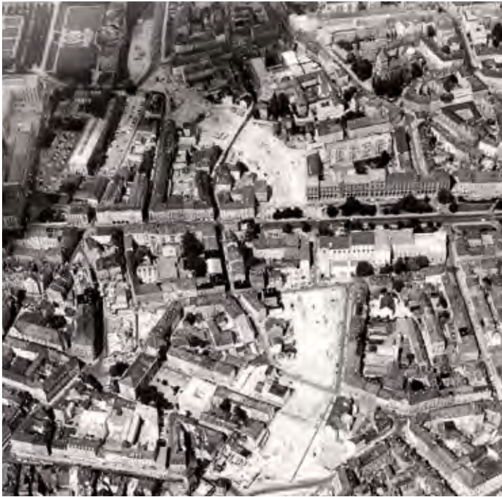
Maximilianstraße – die Baustelle des Altstadtrings vor dem Durchstich, 1967
