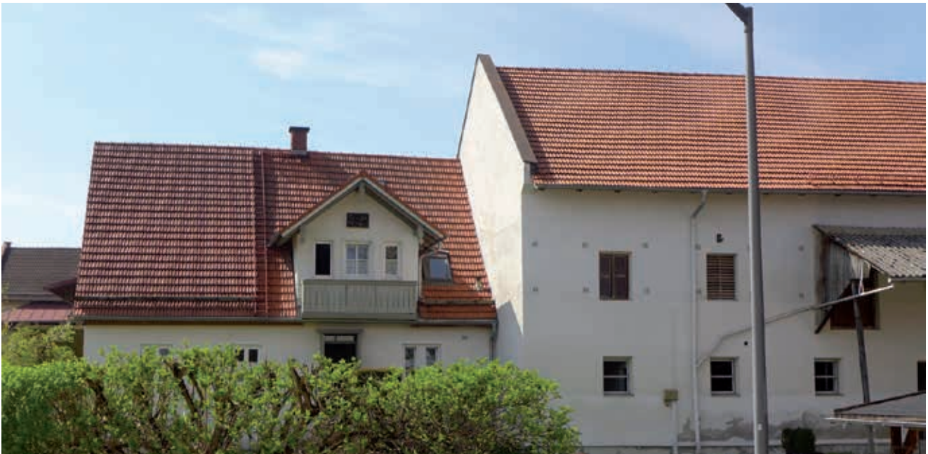
Ein landwirtschaftliches Anwesen im Norden des Dorfplatzes: erdgeschossiges Wohnhaus mit Zwerchgiebel und dem zweigeschossigen Stall-Scheunengebäude
