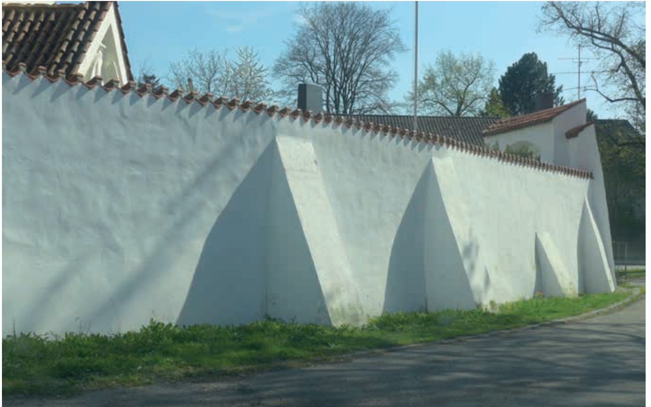
Verputzte, gekalkte Kirchhofmauer mit Strebe Pfeilern und Ziegelabdeckung (Mönch und Nonne)
