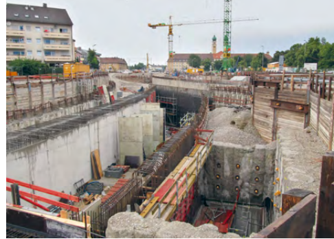
Die Aufnahme von der Tunnelbaustelle Mittlerer Ring Südwest entstand im August 2011 und zeigt die Bauarbeiten bei der Zufahrt zur A 95, Blick in Richtung Altenheim St. Josef.
