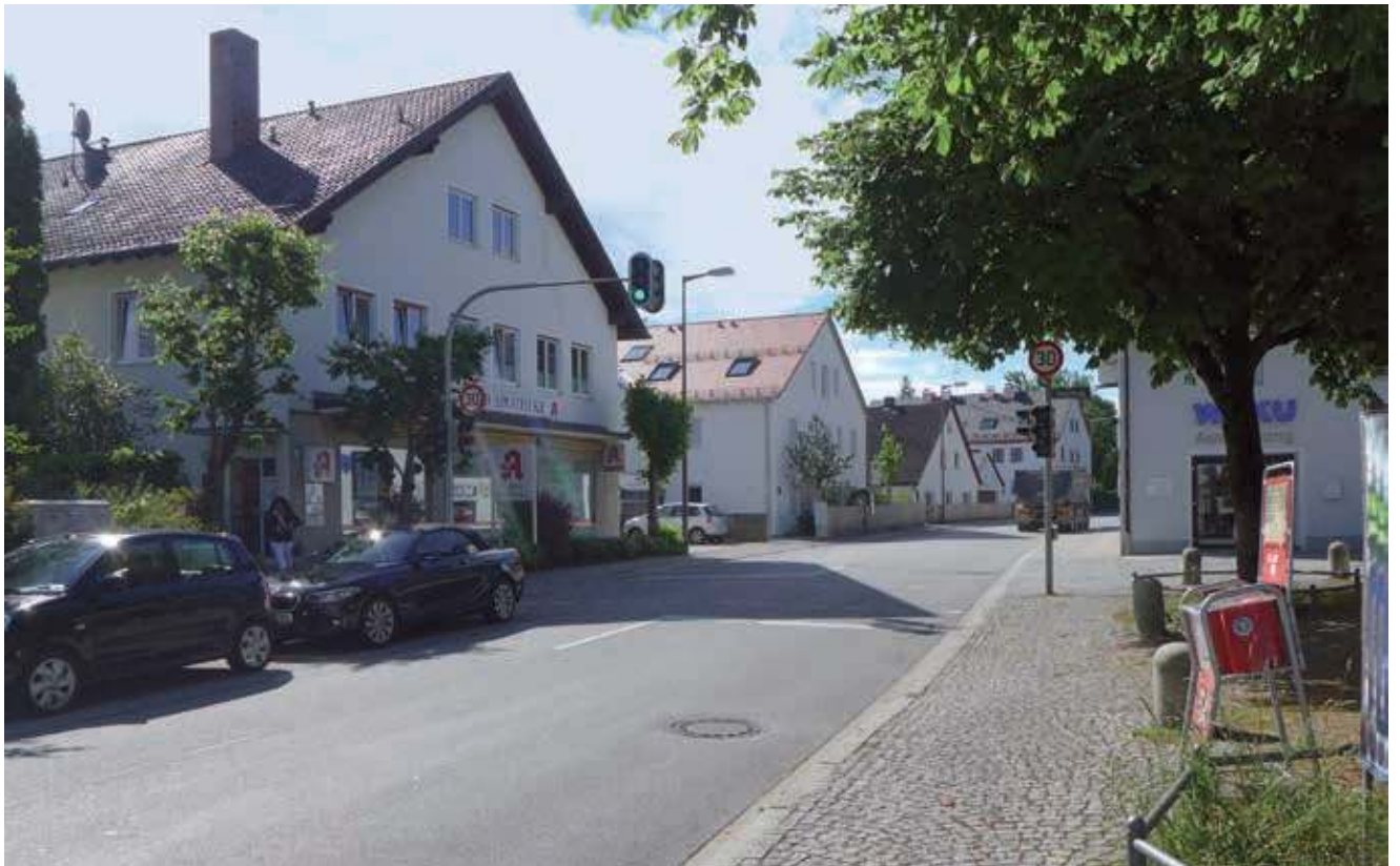
Altostraße: südliche Abfolge giebelständiger Baukörper
