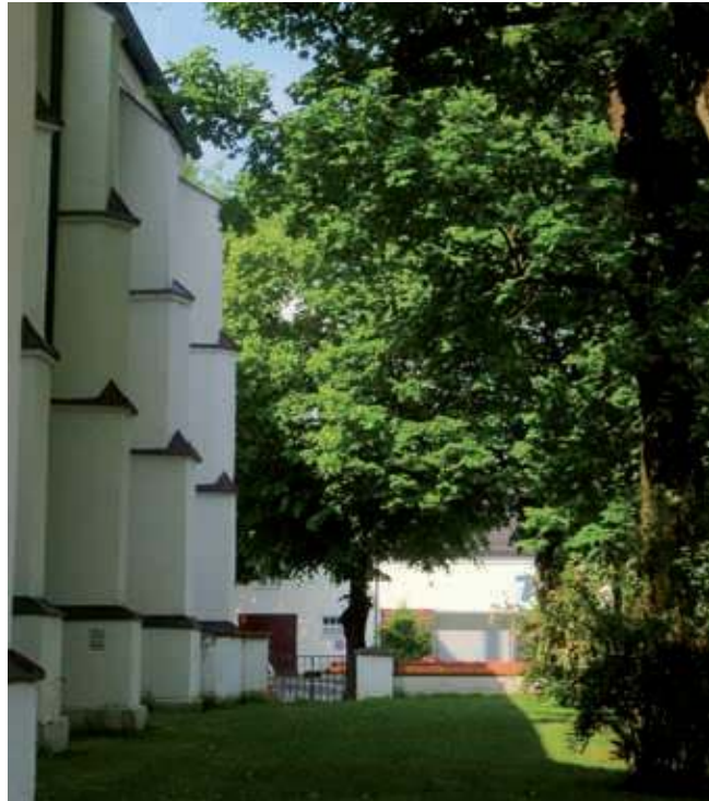
Nordfassade von St. Quirin
