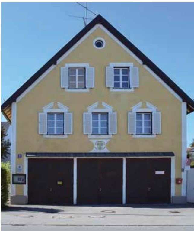
Feuerwehrhaus in der Ubostraße
