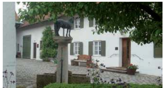
Schwemmstr. 13: sanierte Hoffläche
