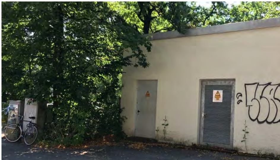
Abbildung 1. Transformatorstation von der Seybothstraße aus gesehen (Blickrichtung: Südost). Quelle: eigene Aufnahme.
