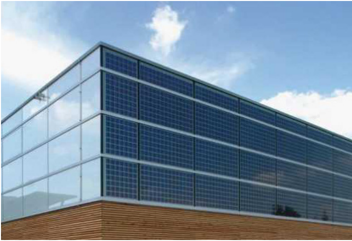
Bild 8: Turnhalle in Regensburg, Ansicht
