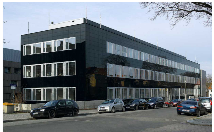
Bild 6: Laborgebäude in Dresden, Ansicht
