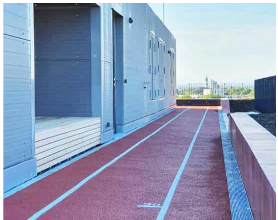
Abb.28. Sportfläche auf dem Dach, SVL, die Macherei, München
