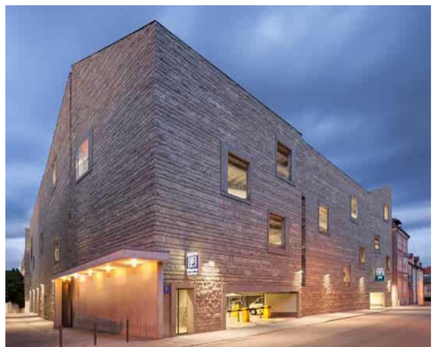
Abb.2. Klassisches Parkhaus im städtischen Kontext. dp architekten, Parken am Petersweg, Regensburg, DE
