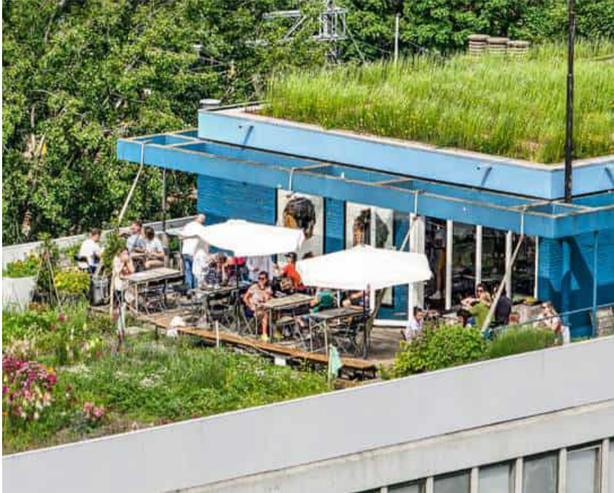
Abb.29. Cafè mit Dachterasse ZUS architecten, De DakAkker, Rotterdam, NL
