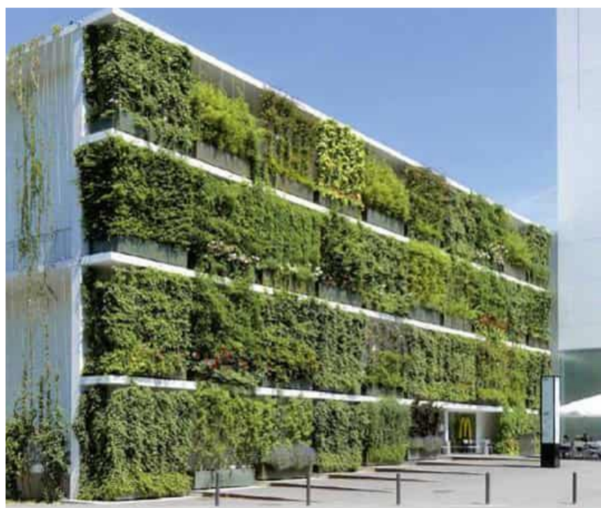
Abb.31. Fassadenbegrünung Grün Statt Grau, Stücki Park Basel, CH
