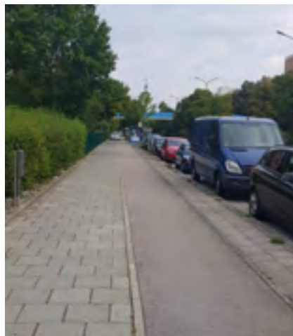
67. An vielen größeren Straßen (Beispiel Quiddestraße) sind baulich geschützte Radwege zu finden. Diese entsprechen in ihrer Breite und Gestaltung nicht mehr den aktuellen Standards.
