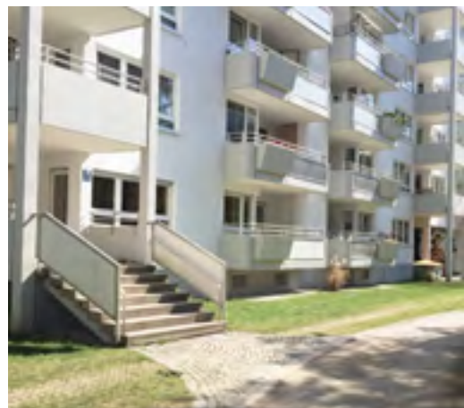
76. Fehlende Rampen bei den Eingängen der Wohngebäude in Neuperlach Ost
