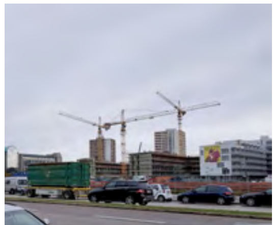
34. Am Hanns-Seidel-Platz befindet sich eine Großbaustelle für ein gemischtes Quartier
