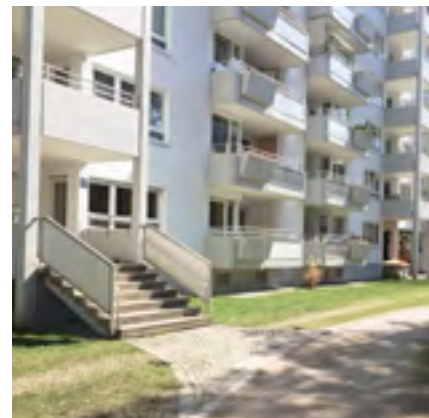
39. Fehlende Rampen bei den Eingängen der Wohngebäude in Neuperlach Ost
