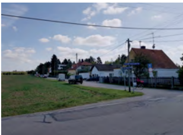
73. An der Arnold-Sommerfeld-Straße entsteht der neue U-Bahn-betriebshof.
