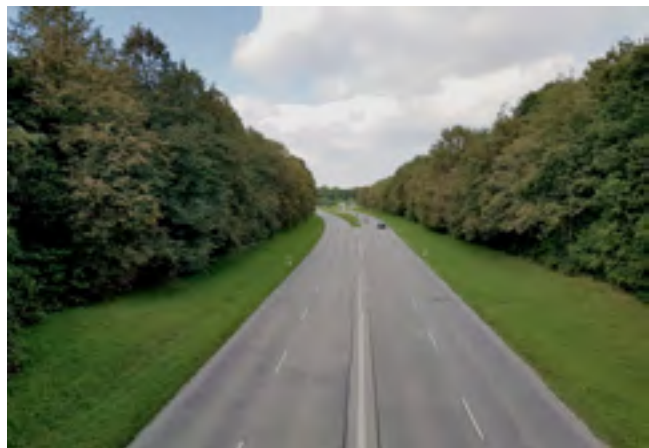
79. Entlang der Ständlerstraße wird die Machbarkeit einer Radverbindung geprüft.
