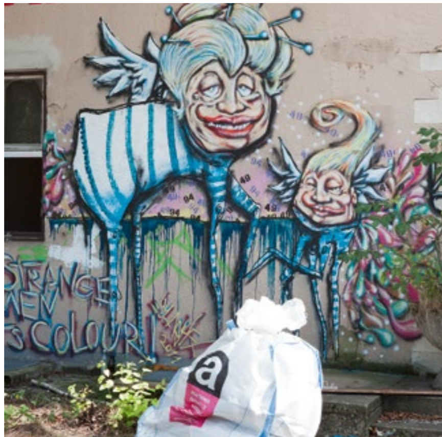
Haus 50 vor der Sanierung
