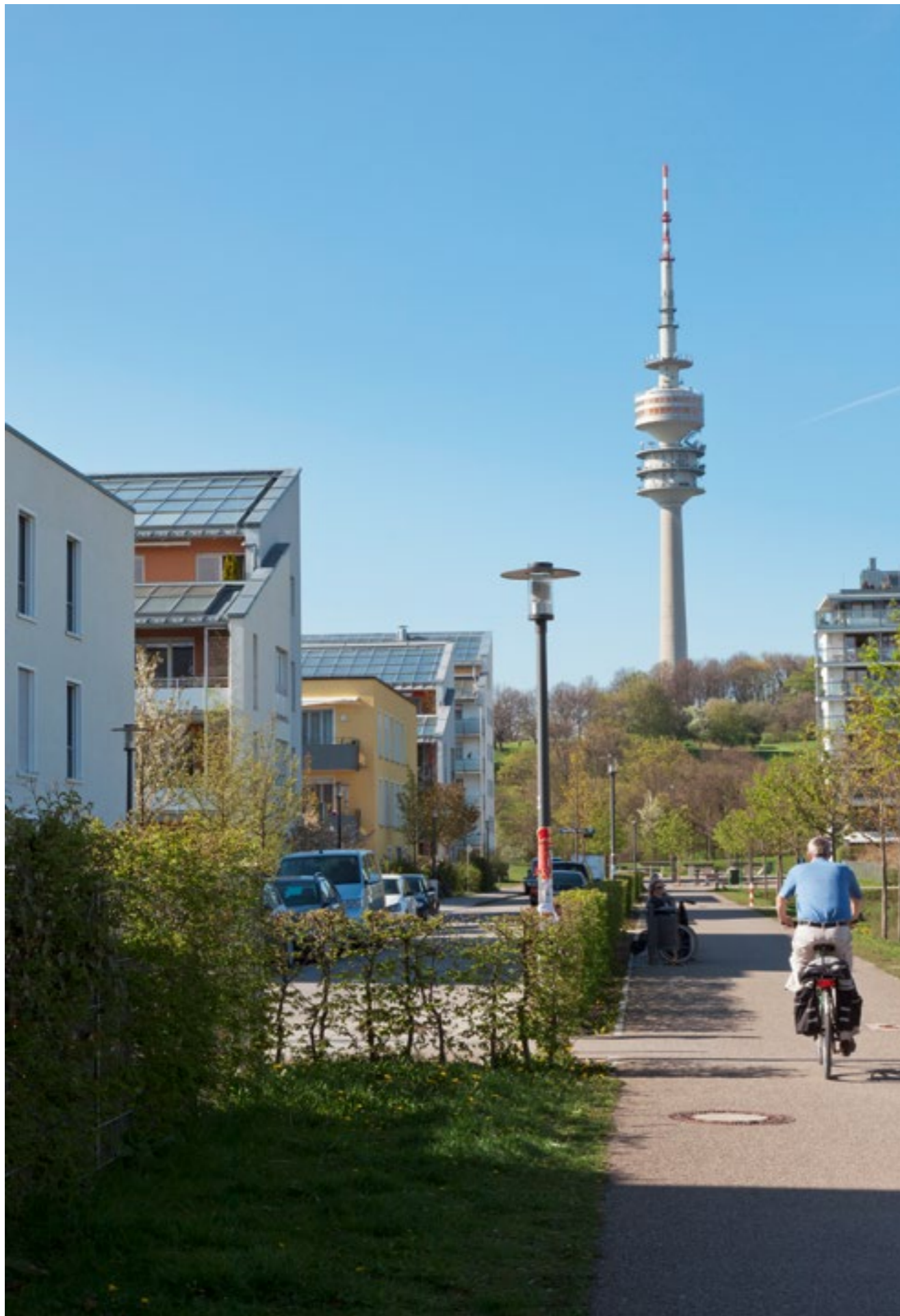
319 Wohnungen werden über die solare Nahwärmanlage im nordwestlichen Teil des Ackermannbogens versorgt.
