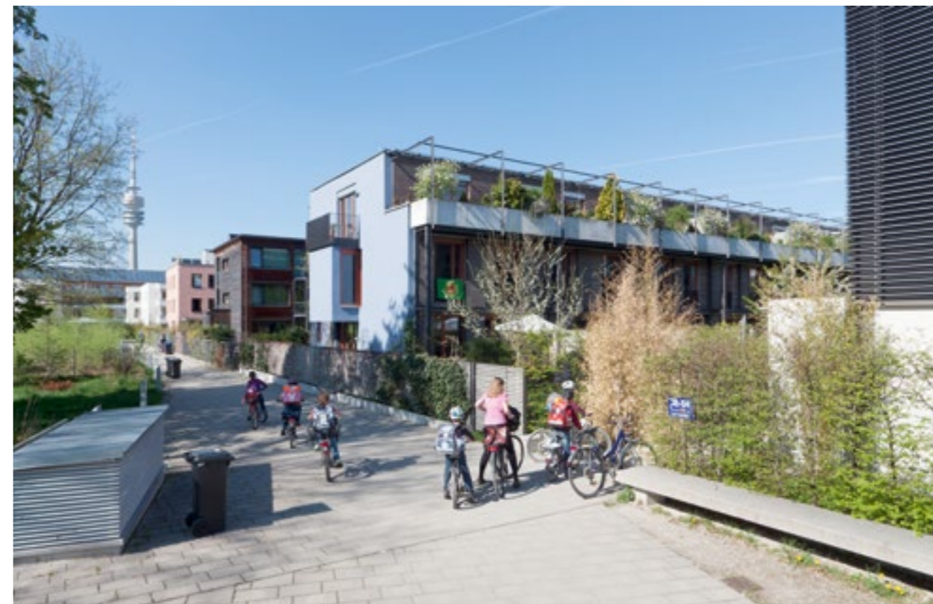
Ansicht des dritten Bauabschnitts im Quartier Am Ackermannbogen
