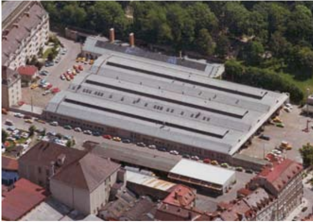
Auf dem Areal des früheren Trambahndepots an der Einstein-/Seeriederstraße wurden Ersatz- und Übergangswohnungen gebaut.
