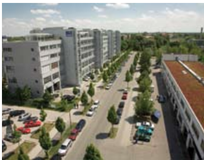
Gewerbehof am Ostbahnhof mit Haager Straße
