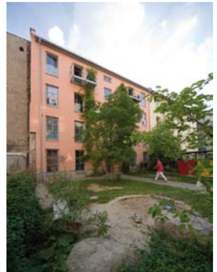
Ateliers im Rückgebäude Lothringerstraße 14
