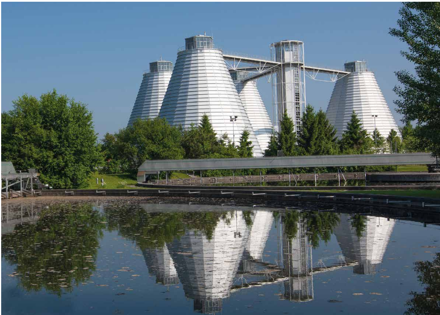
Faultürme mit Nachklärbecken im Vordergrund
