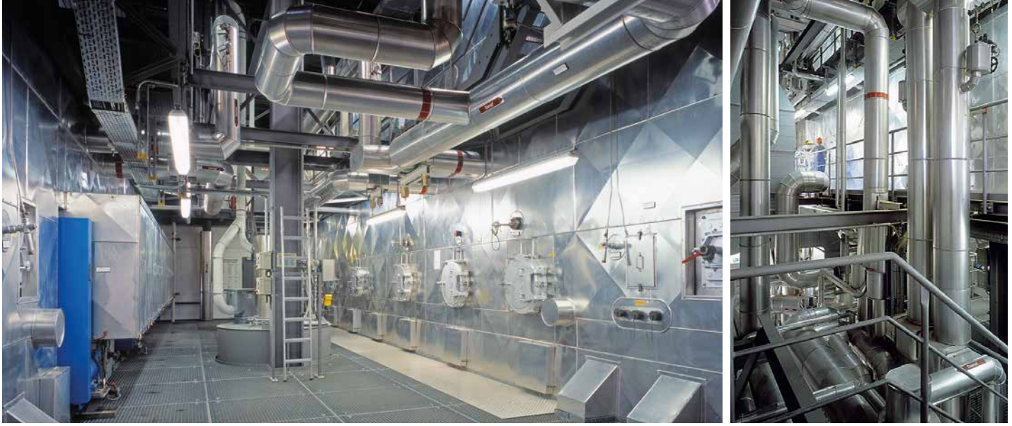
Im Inneren der bestehenden Klärschlammverbrennungsanlage
