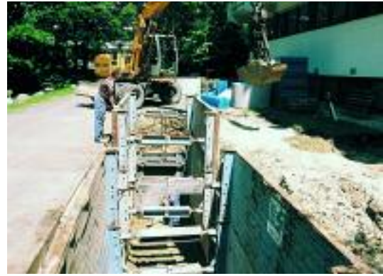
Erstellung der Baugrube für Rigo-fill-Elemente
