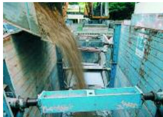
Einbau der Rigo-fill-Elemente – diese besitzen gegenüber Kiesrigolen ein dreifach höheres nutzbares Porenvolumen (oben) Verfüllen der Baugrube (unten)
