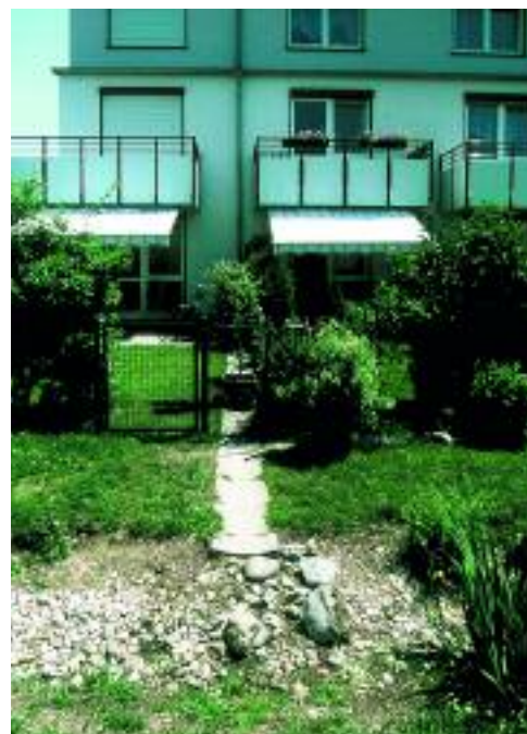
Ableitung des Niederschlagswassers der Dachflächen über eine offene Rinne in eine Kiesmulde
