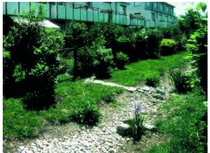
Extensive Dachbegrünung (oben) Versickerungsmulde zwischen den Gärten einer Zeilenbebauung in Riem (unten)
