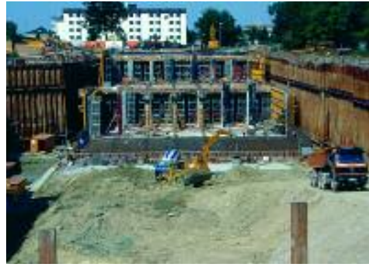
Regenrückhaltebecken Hirschgarten in der Bauzeit
