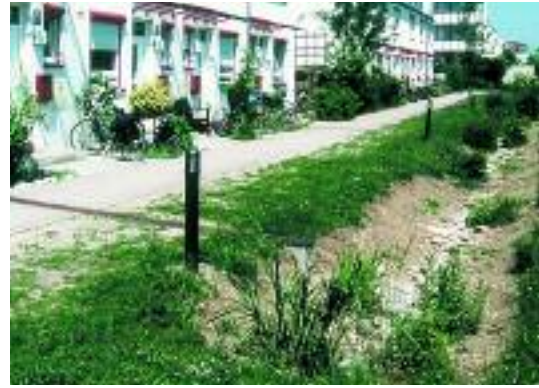
Ableitung des Niederschlagswassers der Dachflächen über gedeckte Kastenrinnen in eine Kiesmulde
