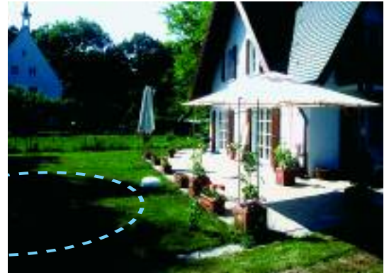
Muldenversickerung im Garten eines Einfamilienhauses. Die Muldenfläche (markiert) bleibt als Rasenfläche erhalten.
