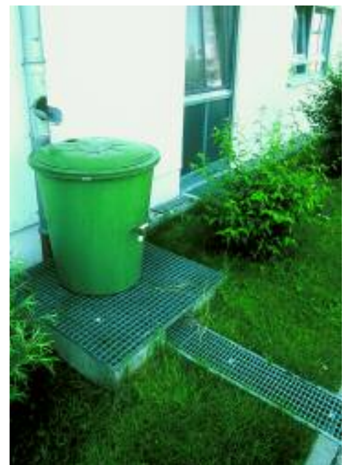
Regentonne – die einfachste Form der Regenwassernutzung
