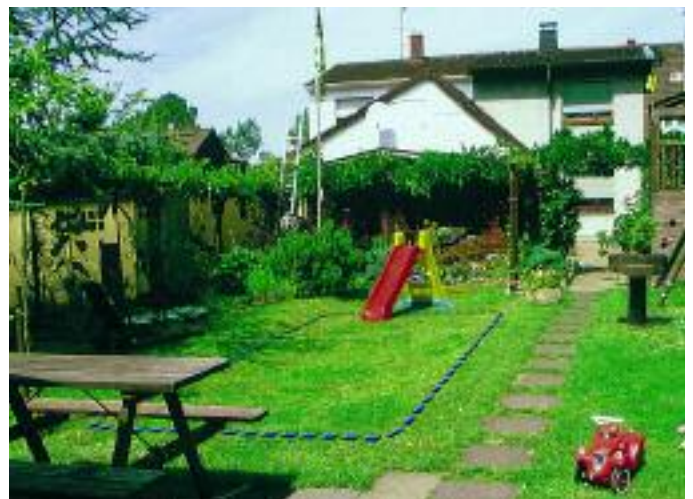
Versickerungsmulde (markiert), die auch als Spielfläche genutzt werden kann
