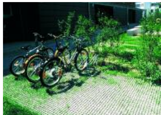
Rasenkammersteine (oben) Schotterrassen (unten)
