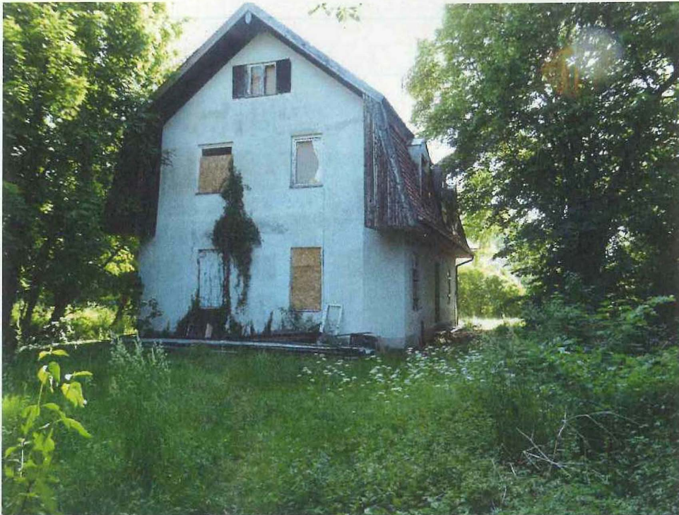
Abbildung 5: Gebäude mit möglichen Fledermausquartieren auf der südlichen Teilfläche. Blick nach Westen. Quelle: Abb. 5- 10 eigene Aufnahmen
