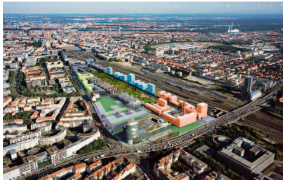
Arnulfpark von Nordwesten
