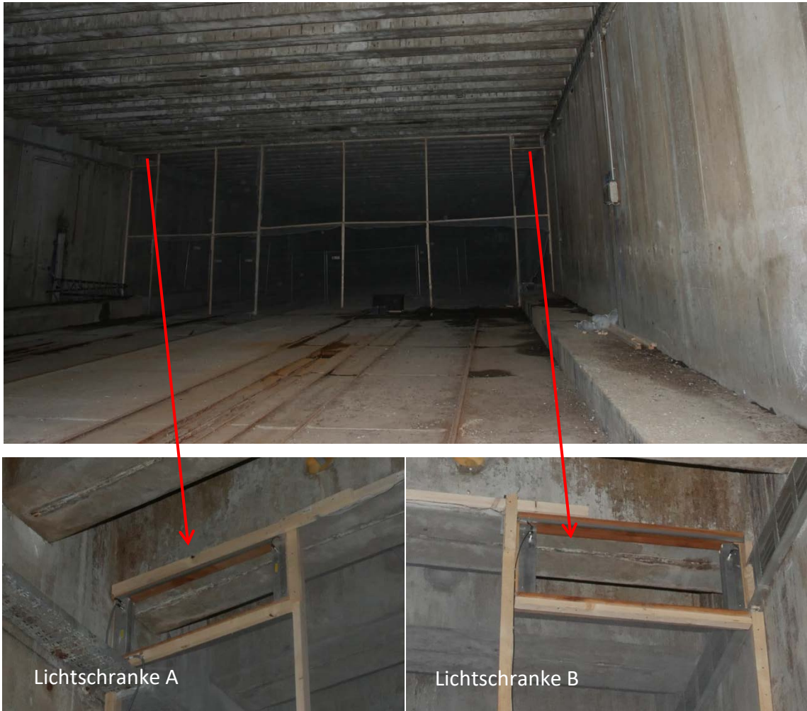
Abb. 5: Die Große Halle wurde der vermeintlich Dunkelbereich mit einem Gerüstnetz abgetrennt. Sowohl auf der rechten als auch auf der linken Seite wurde deckennah jeweils eine Lichtschranke installiert. (Quelle: Kugelschafter 2020)
