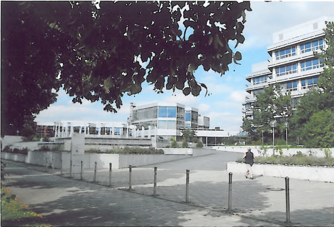
Gebäudekomplex der Deutschen Rentenversicherung Bayern Süd, nordöstlich des PEP auf der Ostseite der Thomas-Dehler-Straße, Blick von Süden (Architekt von Branca)
