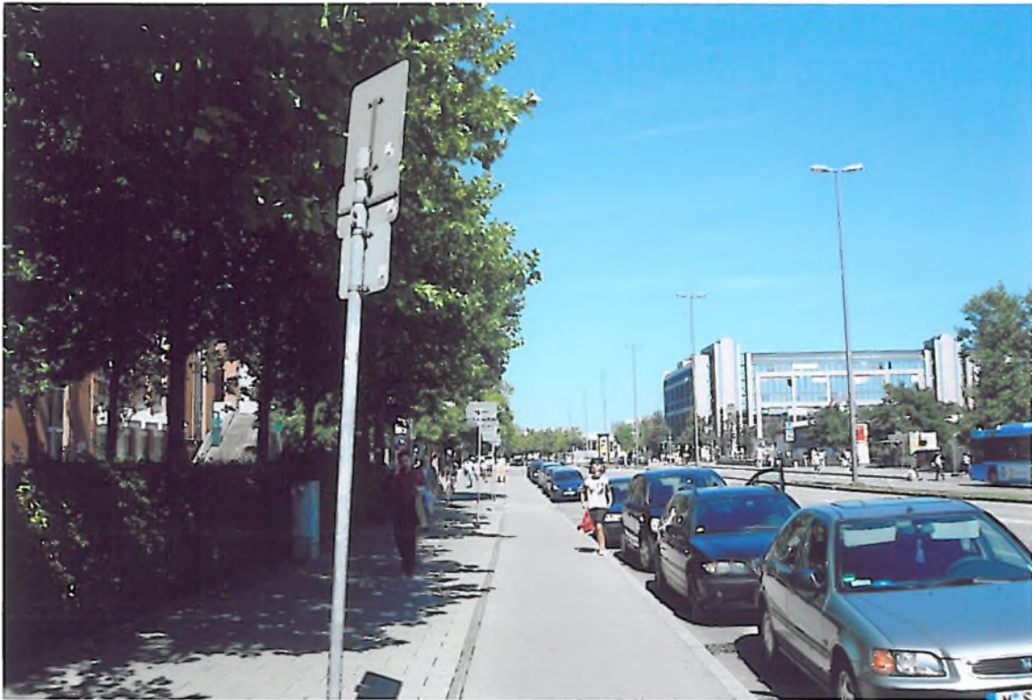
Abschnitt südlich des Überganges vom PEP zum Busbahnhof; links: Südteil des PEP, rechts: Blick zum Gebäude von Wacker Chemie, davor U-Bahn-Zugang und Kiosk am Weg zum H.-Seidel-Platz
