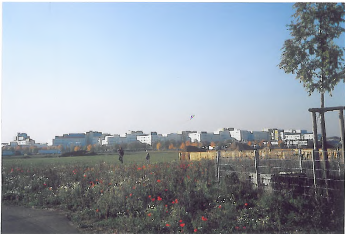
Blick von Südosten, von Waldperlach, über den südöstlichen Freiraum und die unbebauten Areale östlich der Heide- und Arnold-Sommerfeld-Straße
