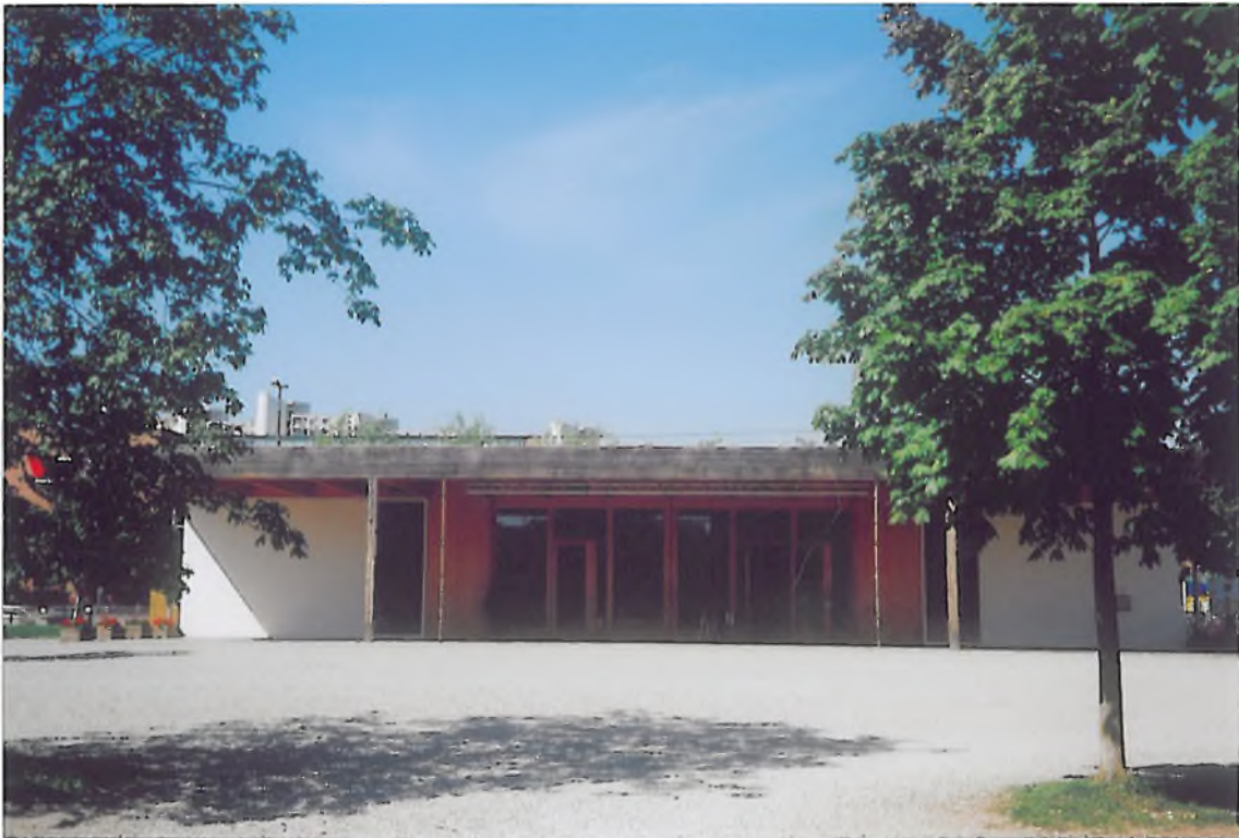
Provisorisches Kulturhaus: Eingangsseite auf der Ostseite des Gebäudes, vom Hanns-Seidel-Platz aus
