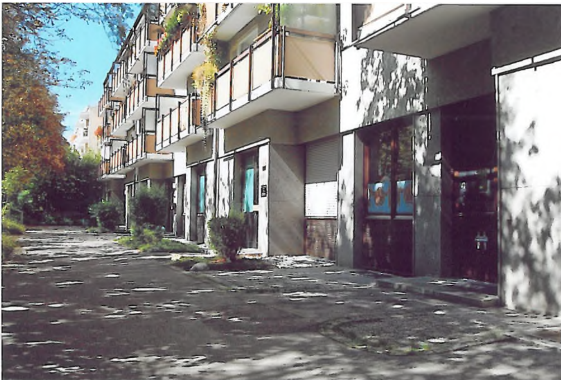
Erdgeschosszone für Läden in der nördlichen Bauzeile, an der Ecke Heinrich-Lübke-Straße
