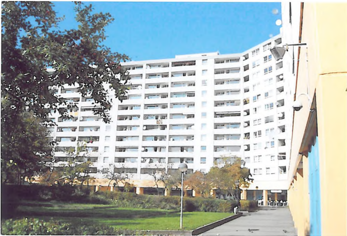
Gebäuderiegel mit Graf-Zentrum, Südseite
