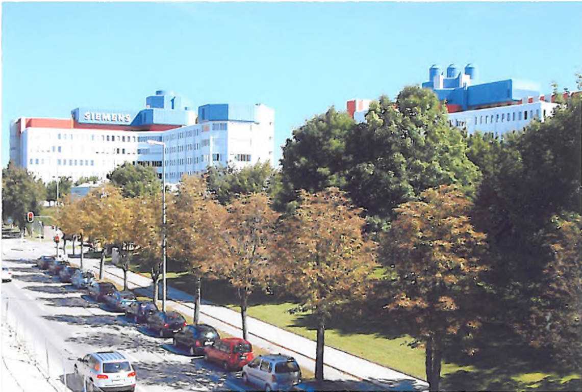
Blick vom über der Carl-Wery-Straße liegenden U-/ S-Bahnhof Neuperlach Süd nach Norden auf die Westseite des nördlichen Teils des Baukomplexes
