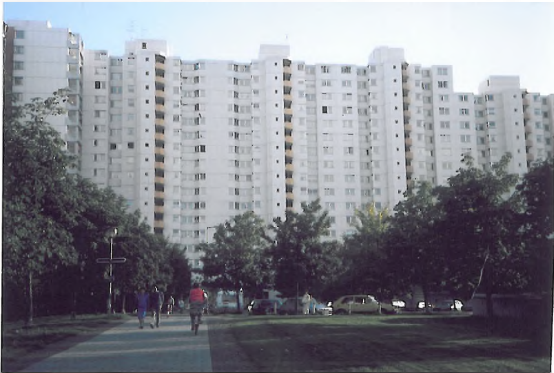
Südteil, südlicher Teil, Nordansicht mit Nord-Süd-Fußweg im Wohnring
