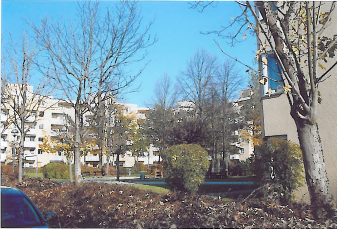
Innenhof eines Baublocks westlich der Therese-Giehse-Allee
