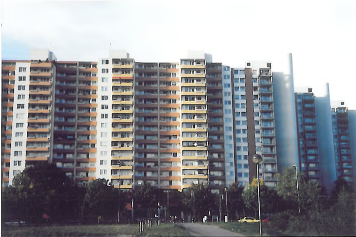
Südteil: Blick von Süden auf den höchsten Gebäudebereich
