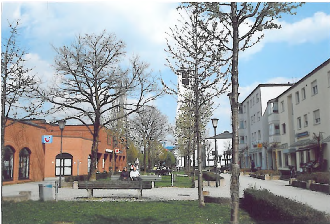
Nahversorgungszentrum zwischen Evangelischem Gemeindezentrum und Therese-Giehse-Allee, Blick vom Platz vor dem Evangelischen Gemeindezentrum Richtung Nordosten
