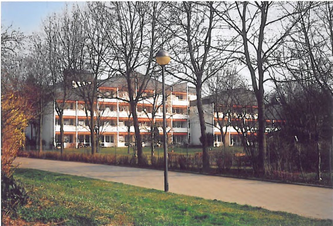
Blick von Westen auf den nach Westen zum Dorfrand orientierten Wohnflügel des Altenheims St. Michael,
