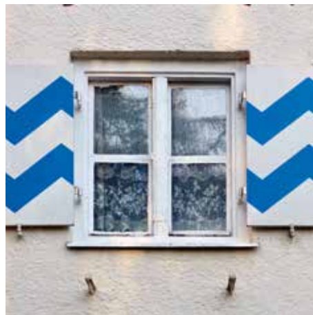
Fenster mit Klappläden
