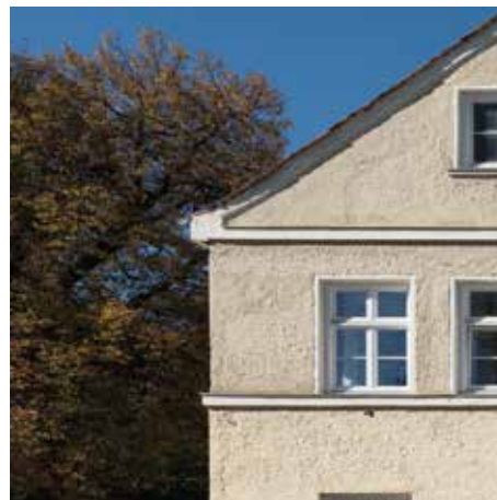
Fassadendetails des ehem. Schulhauses
