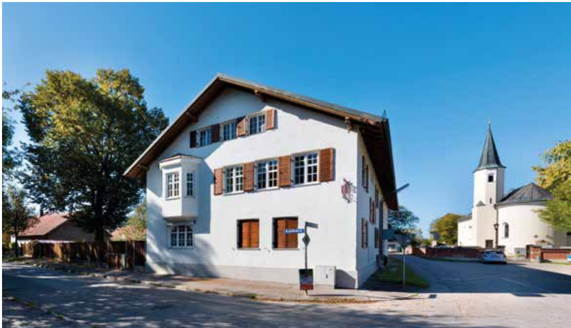
Ehem. Bauernhof an der Kuniuhstraße
