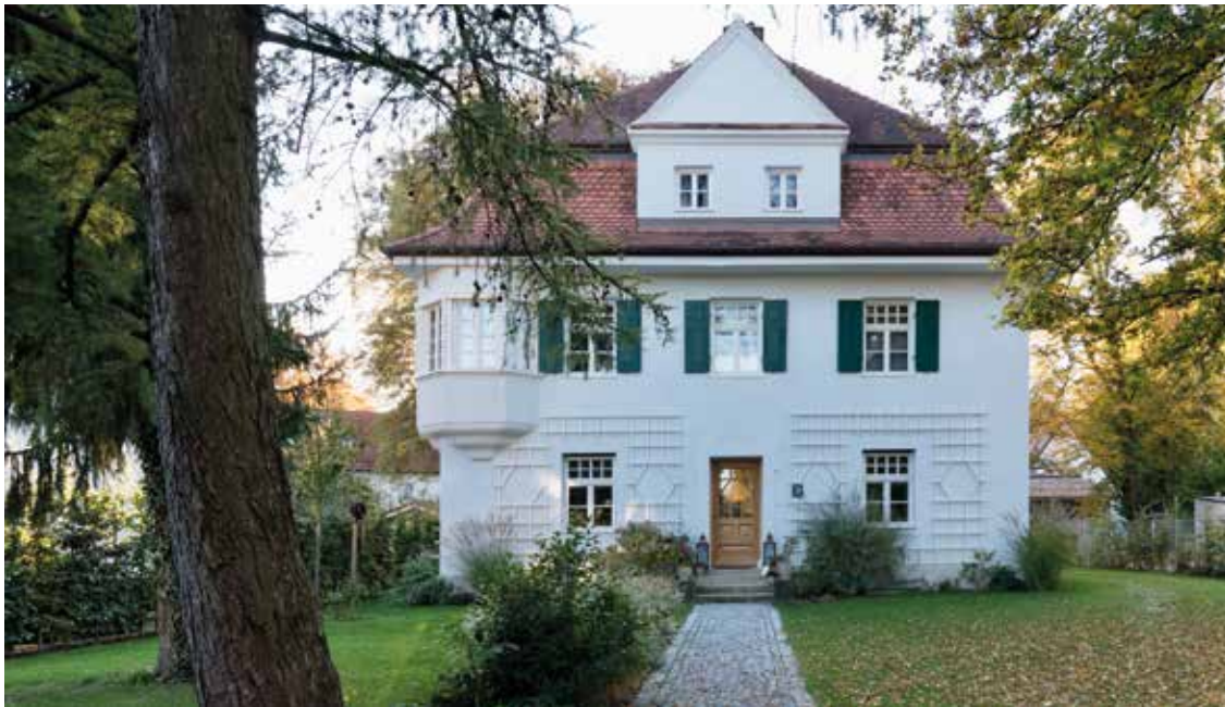
Ehem. Lehrerwohnhaus an der Schussenrieder Straße
