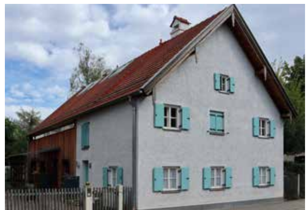
Hist. Kopfbauten mit neuen Anbauten
