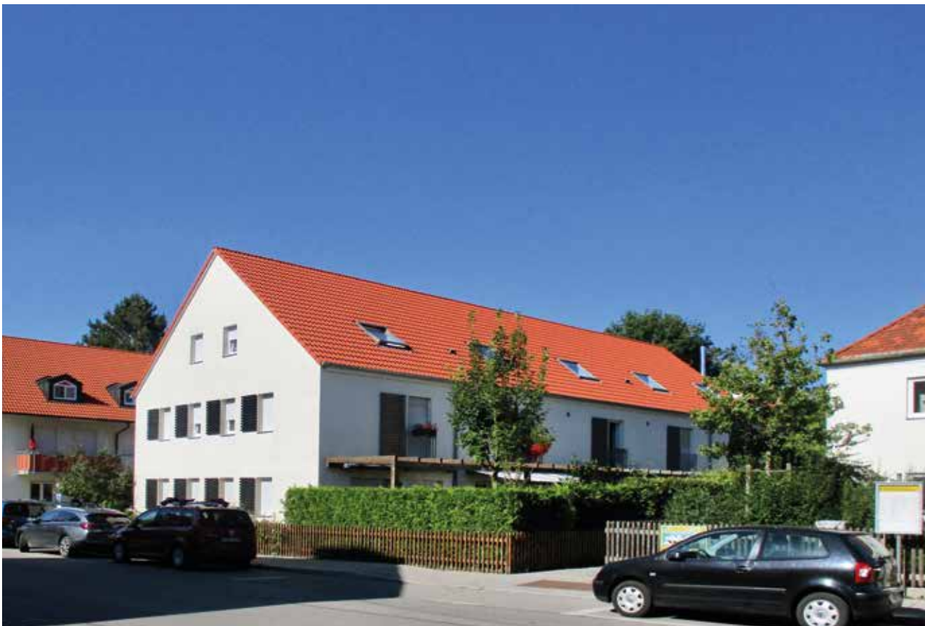
Ensemblegerechter Neubau in der Altostraße
