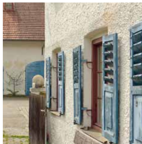
Kastenfenster mit Klappläden
