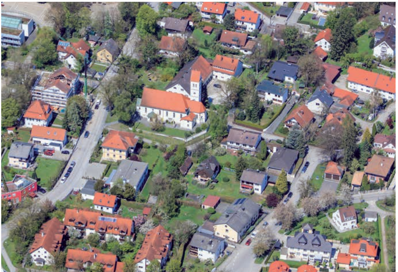
Blick von Südosten
