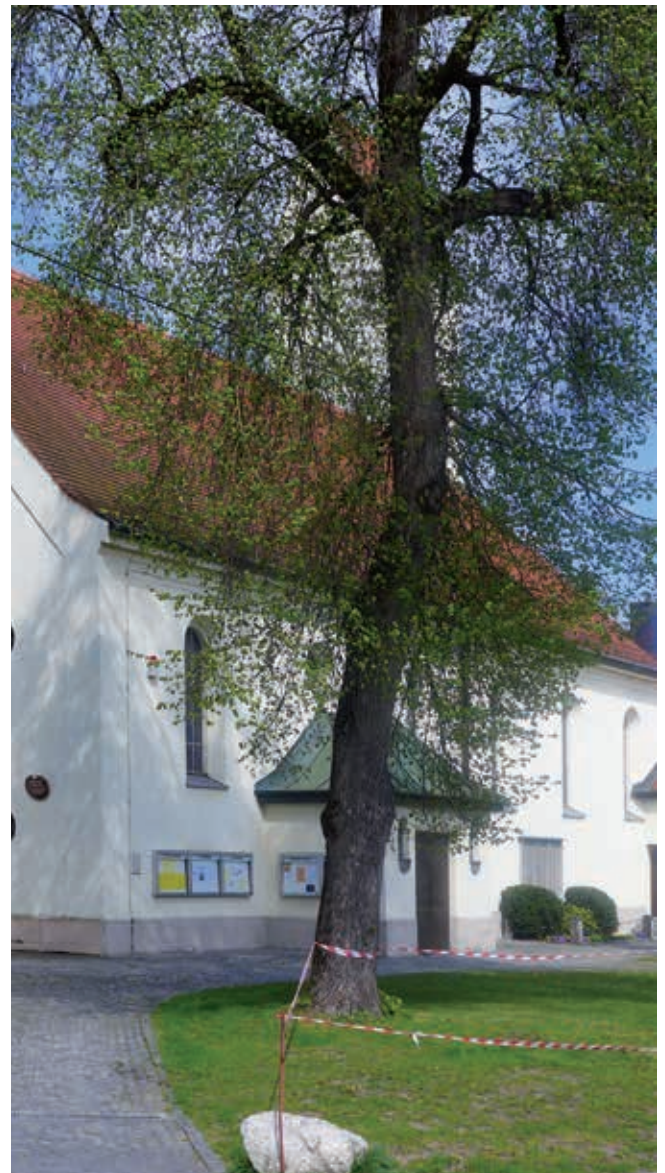
Ostfassade des Langhauses von St. Michael
