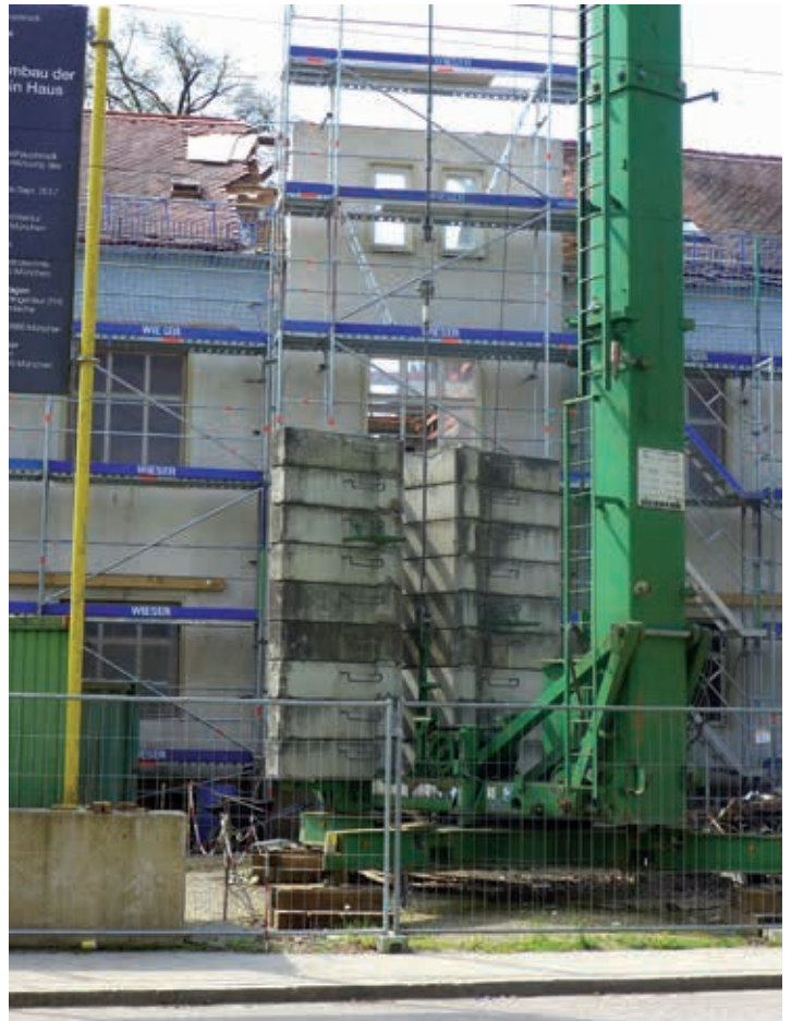
Schussenrieder Str. 5: „Haus der Kinder“ während der Sanierungsarbeiten
