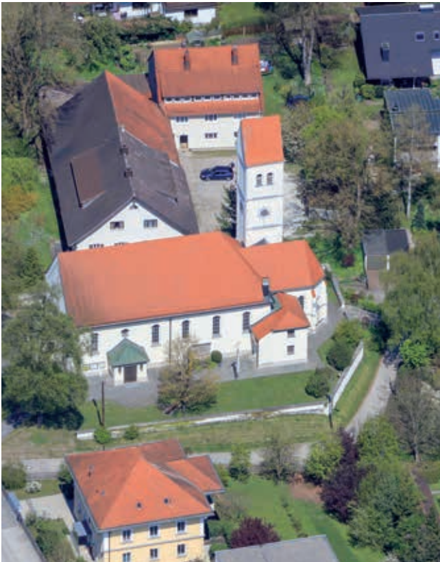
Das Ensemble mit Blick nach Norden, 2017
