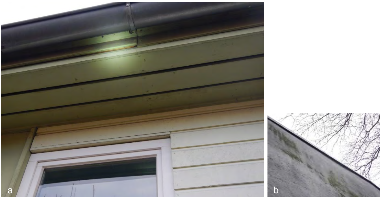
Abb. 5: Gebäudenischen (Abbruch) (eigene Aufnahmen)
