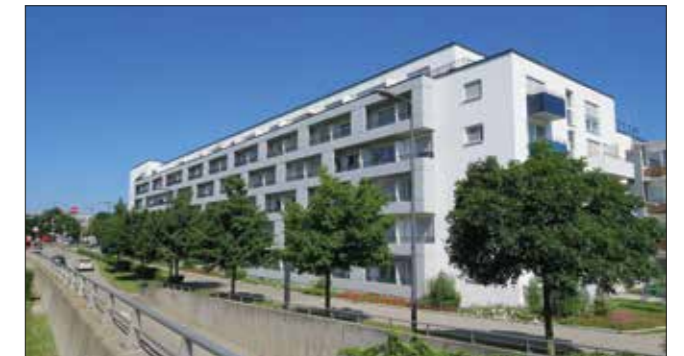
Straßenseite des Studentenwohnheims - Knorrstraße 2 (2015)
