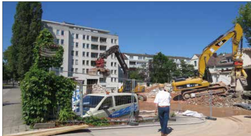
Abbrucharbeiten Petuelring 104 / Frohschammerstraße 2 und 4 (2015)
