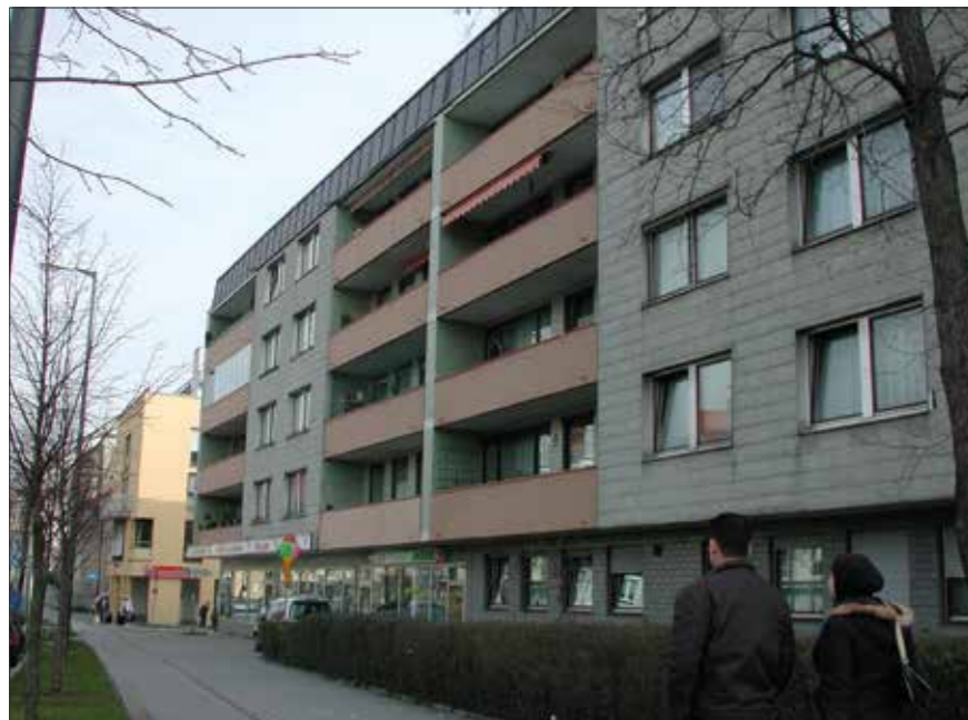
Bestandsbebauung mit Wohnen und Gewerbe - Ansicht Straßenseite - Frauenstadtstraße 11 und 13 (2007)
