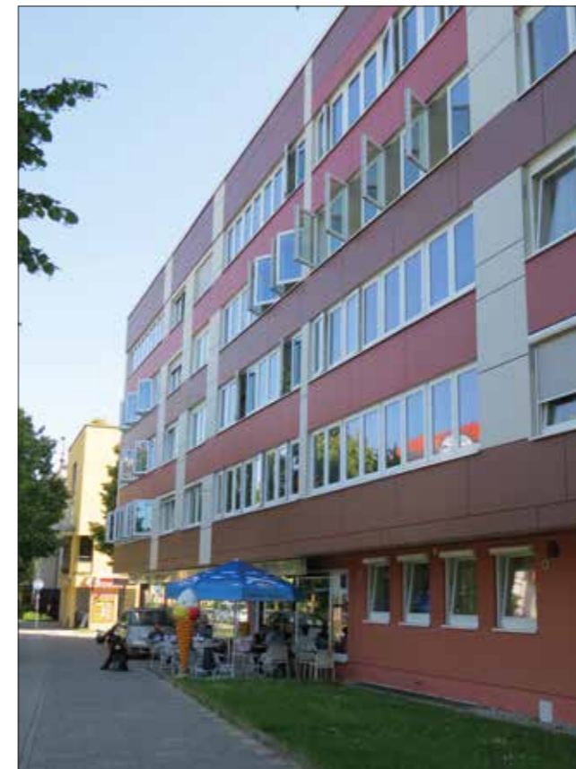
Fassadensanierung Straßenseite - Frauenstadtstraße 11 und 13 (2015)
