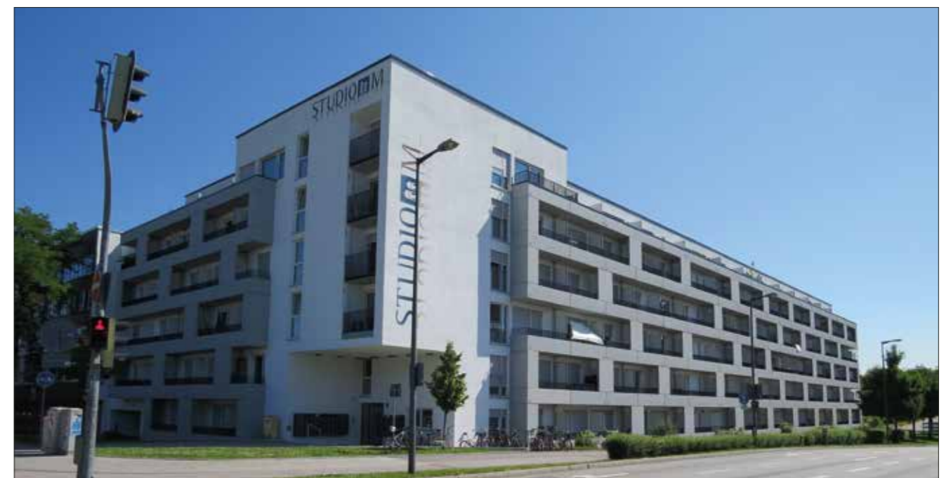
Studentenwohnheim als Blockrandschließung - Knorrstraße 2 / Ecke Petuelring (2015)
