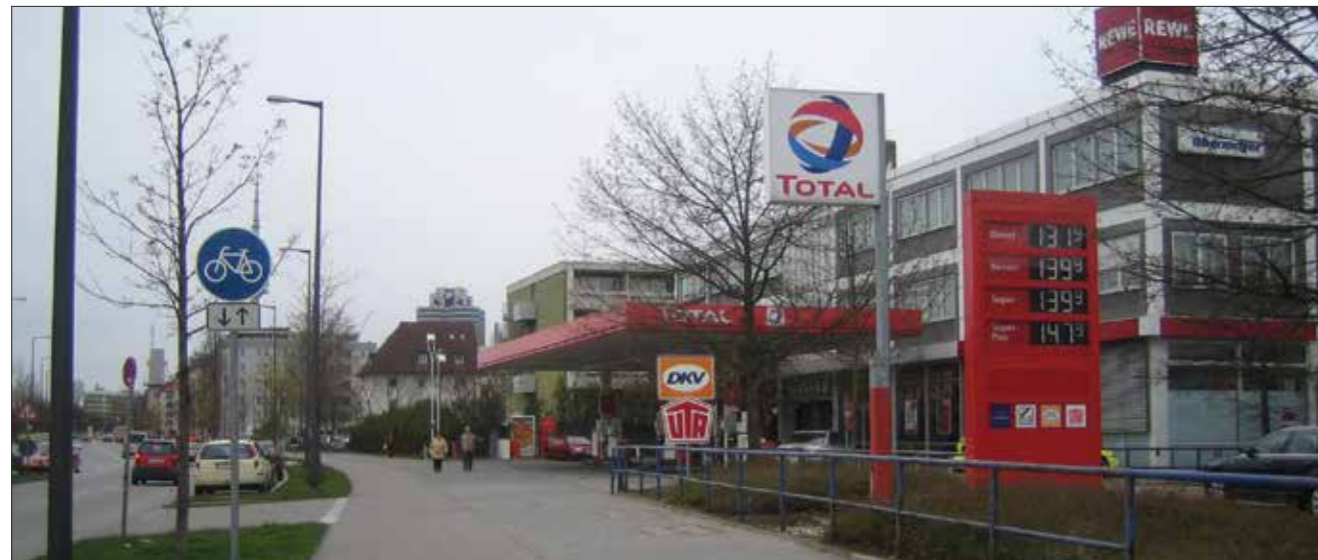
Bestandsbebauung mit Tankstelle und Einkaufsmarkt - Petuelring 96 (2008)
