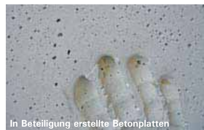
In Beteiligung erstellte Betonplatten
