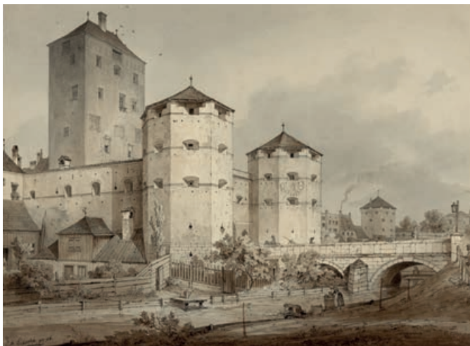
Abb. 30: Das Isartor nach der Restaurierung durch Friedrich Gärtner, Aquarell von Carl August Lebschée, 1846
