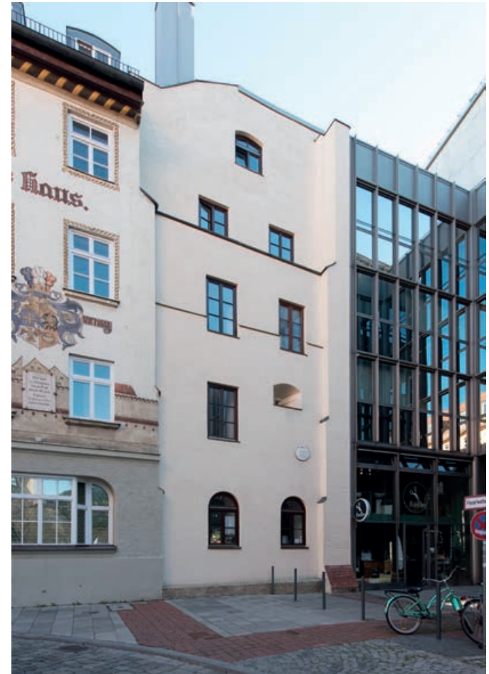
Abb. 25: Die erhaltene Nordmauer des Lueg ins Land mit ergänztem Grundriss im Straßenpflaster
