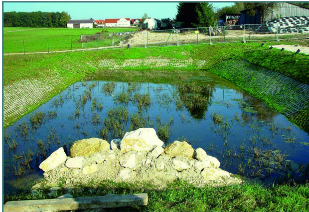
Abb. 9: Rückhaltung und Reinigung des Wassers in einer Bodenfilteranlage
