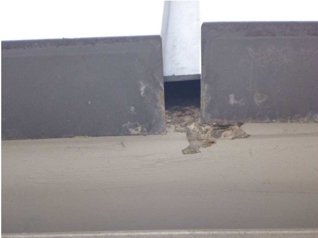
Abb. 3.e ... mit unterseits offenen Verbindungselementen
