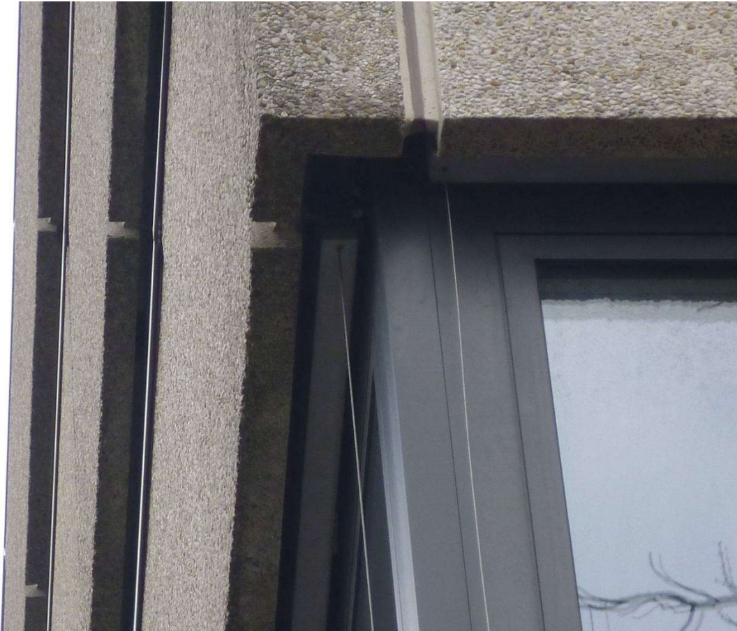
Abb. 3.c Nur über "Umwege" zu erreichender Hohlraum unter der Außen-Verkleidung
