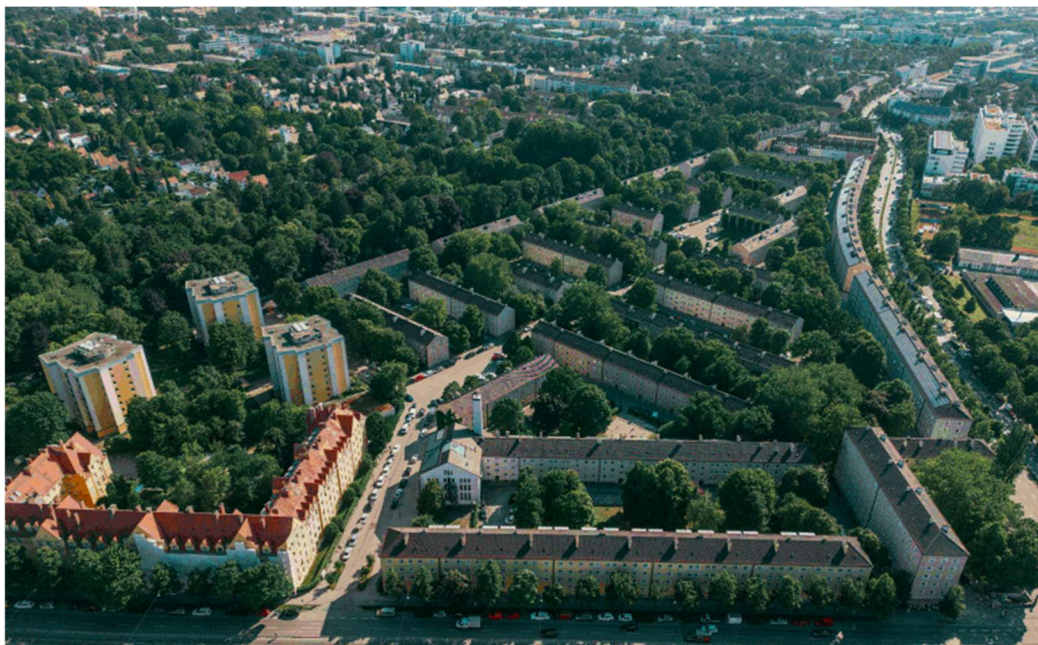
Abbildung 22: Luftbild Pilotprojekt „Ramersdorf Süd“
