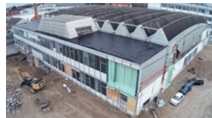
Vor der Renovierung
