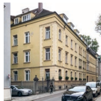
Vor der Renovierung
