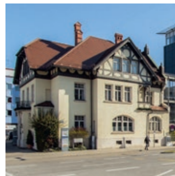
Vor der Renovierung
