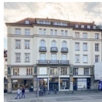
Vor der Renovierung
