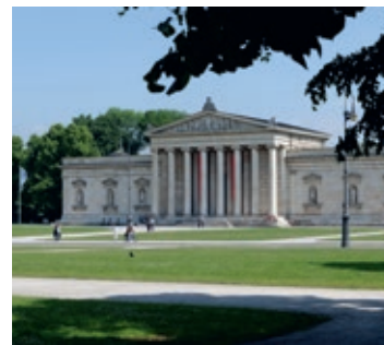
Vor der Renovierung
