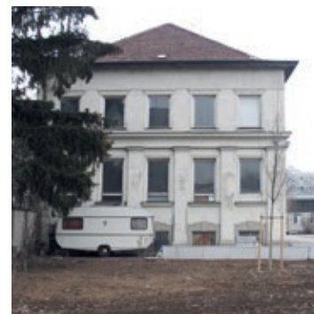
Vor der Renovierung
