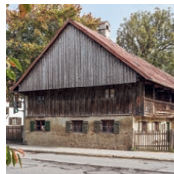
Vor der Renovierung
