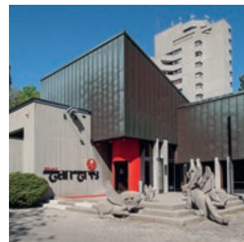
Vor der Renovierung
