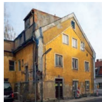
Vor der Renovierung
