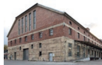
Vor der Renovierung
