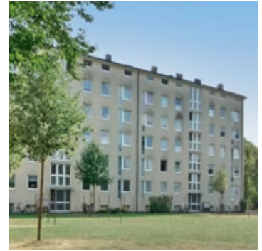
Vor der Renovierung
