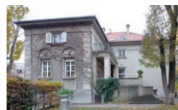
Vor der Renovierung
