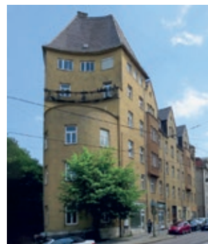
Vor der Renovierung
