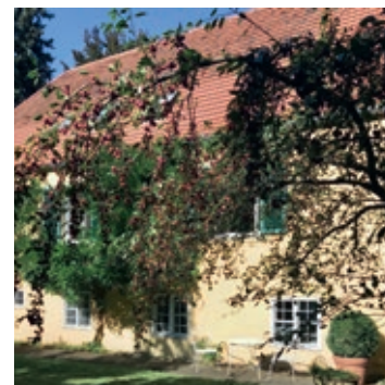
Vor der Renovierung
