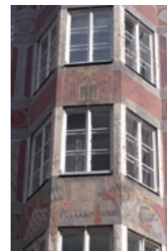
Vor der Renovierung
