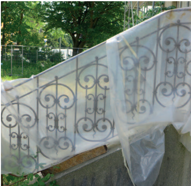
Handwerkliche Sanierung eines schmiedeeisernen Handlaufs
