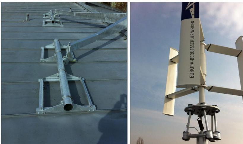
Abbildung 51: Dachmontage einer 1,3 kW vertikalen KWEA auf dem Dach der Berufsschule Weiden i.d. Opf.<sup>99</sup>
