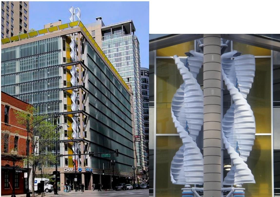
Abbildung 26: Savonius-Rotoren am Greenway Self Park in Chicago <sup>43</sup>
