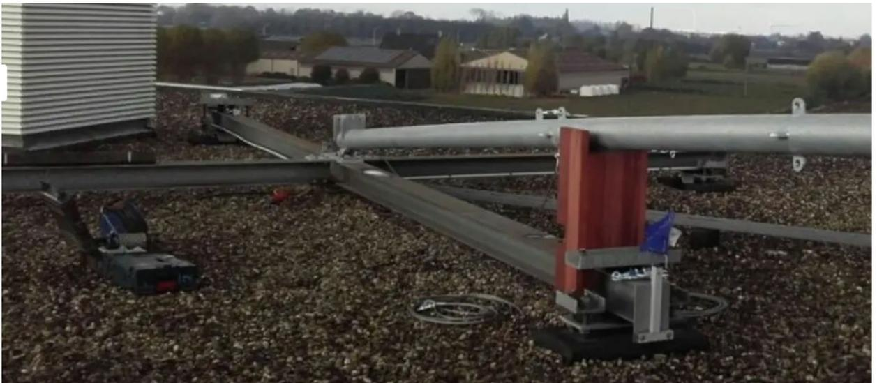
Abbildung 71: Dachanbringung Braun Antaris 7,5 kW und 9 m Mast (Quelle: Braun Windturbinen)
