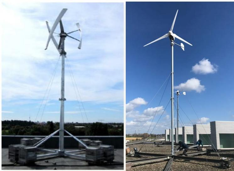
Abbildung 48: Dachmontage mit Ballastierung<sup>87</sup> und Dachmontage mit fester Anbindung<sup>88</sup>
