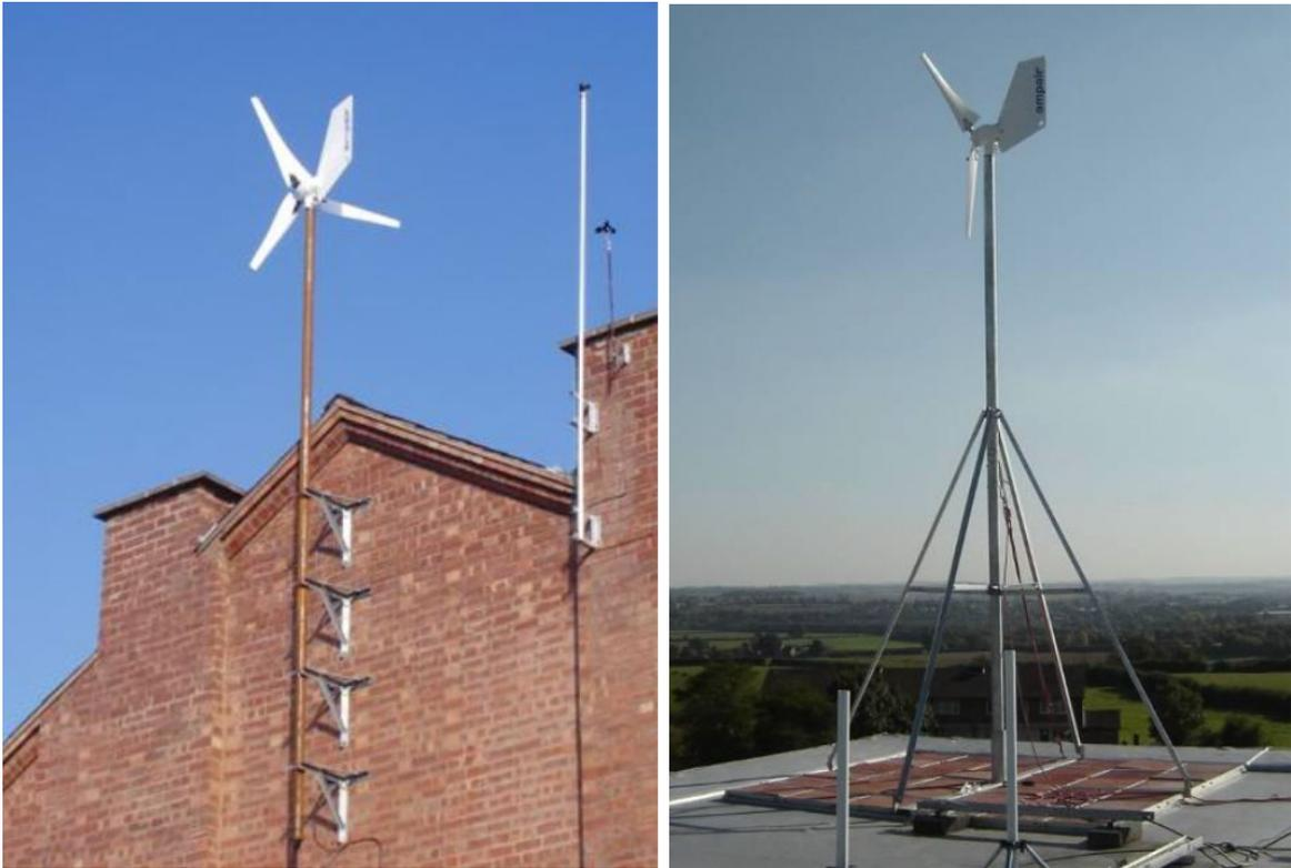
Abbildung 25: verschiedene Möglichkeiten der Befestigung am Gebäude im Warwick Wind Trials Projekt<sup>41</sup>
