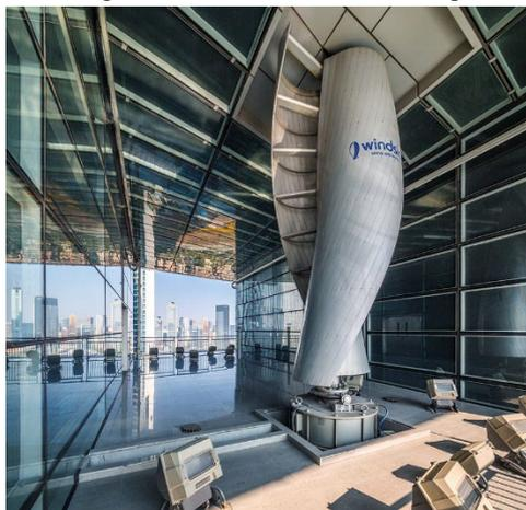
Abbildung 30: Savonius-Rotor im Pearl River Tower, China <sup>49</sup>
