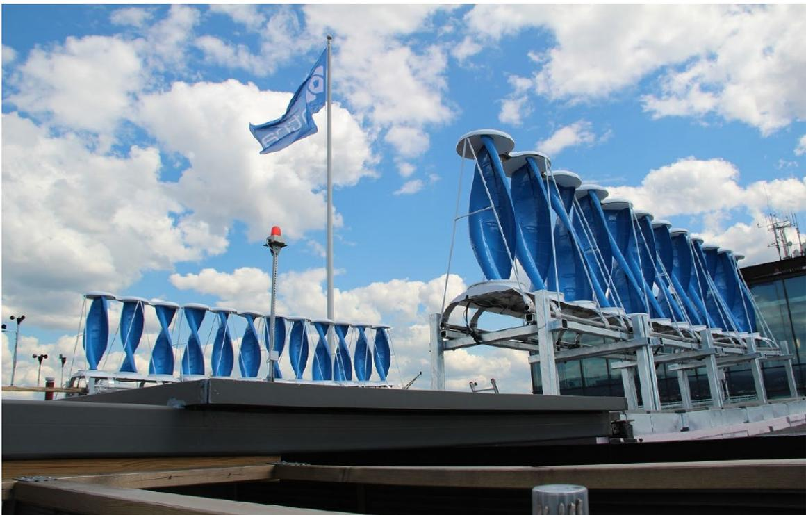
Abbildung 19: Kleinwindkraftanlage (Savonius-Rotoren) in Oslo<sup>36</sup>
