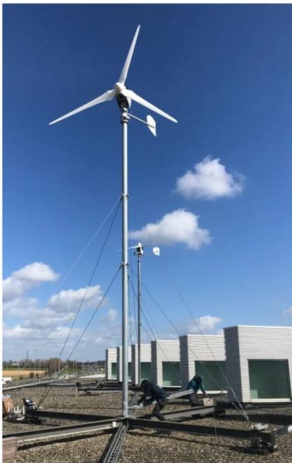
Abbildung 18: Braun Antaris 7,5 kW, 9 m Kippmast, Dachmontage <sup>35</sup>
