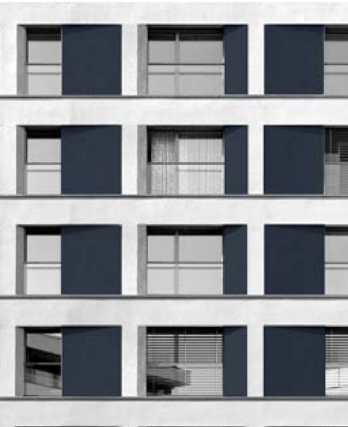
1 Gebäudeintegrierte PV als Teil der Fassadenöffnung
