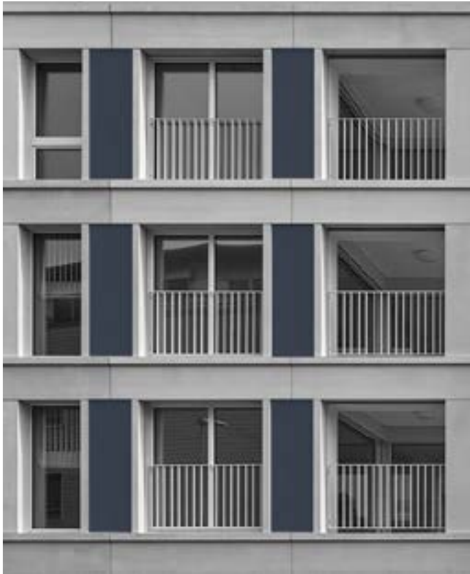
4 Gebäudeintegrierte PV als Stütze Vertikale Ausrichtung, Teil der massiven Fassade
