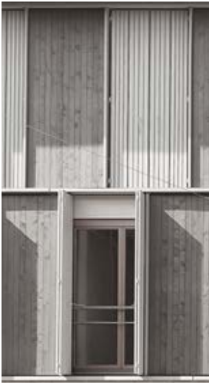
3 Glatte Holzstruktur mit vorgesetzten Holzprofilen
