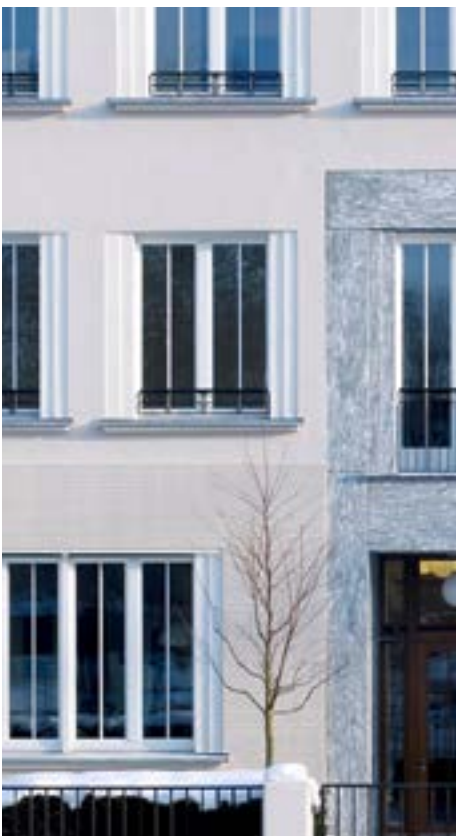
2 Strukturierter Putz im Sockelbereich
