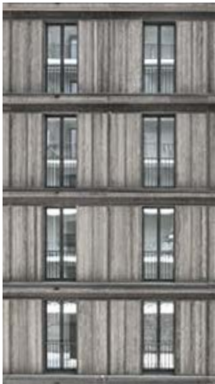
1 Plastizität durch betonte Gesimsbänder
