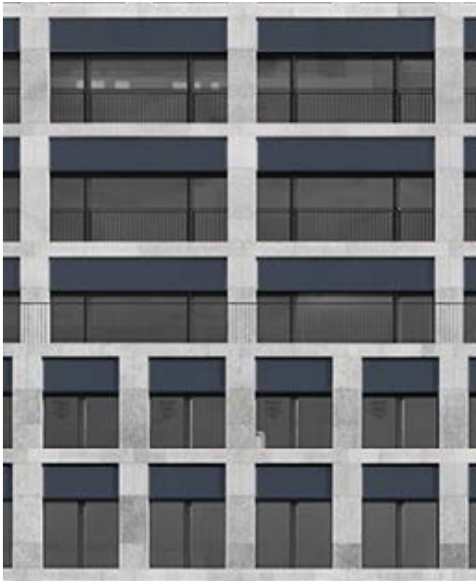
2 Gebäudeintegrierte PV als Teil des Fensters
