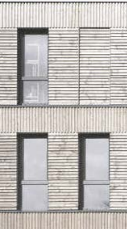
4 Vertikale + Horizontale Lattung mit durchlaufender Fensterbank
