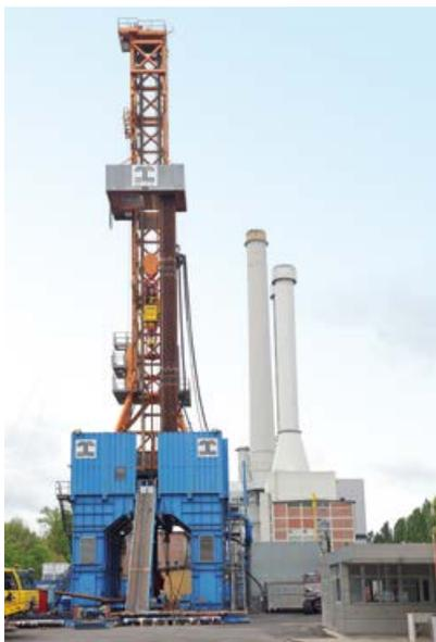
Bohrarbeiten für Deutschlands größte Geothermieranlage am Heizkraftwerk Süd in Thalkirchen
