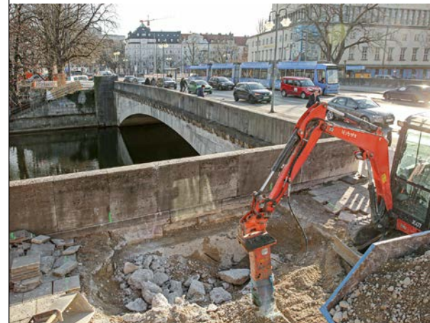
Die Ludwigsbrücke wird saniert, Radler und Fußgänger erhalten mehr Platz.
