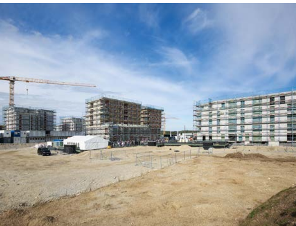
Freiham Nord: Richtfest für 214 neue Wohnungen der GWG
