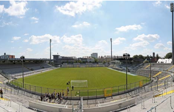
Das Städtische Stadion an der Grünwalder Straße: Die Zuschauerkapazität soll erhöht werden.
