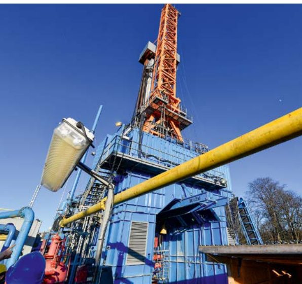
Die Bohrungen für eine Geothermieanlage am Standort HKW Süd verlaufen erfolgreich.
