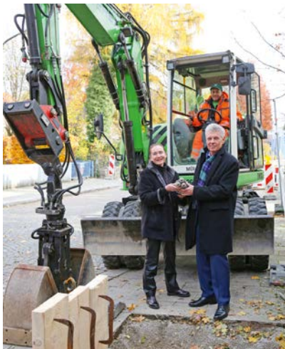
OB Dieter Reiter und Baureferentin Rosemarie Hingerl starten die ersten Maßnahmen zur Verlängerung der U5 vom Laimer Platz nach Pasing.
