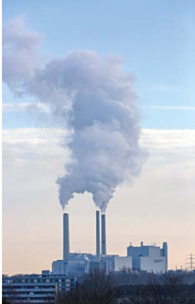
Das Heizkraftwerk München Nord wird ab Mai 2020 mit größtmöglicher CO 2 -Reduktion betrieben und der Kohleblock, sobald es möglich ist, ganz abgeschaltet werden.
