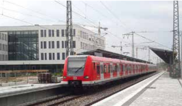
Die neue S-Bahn-Station Freiham
