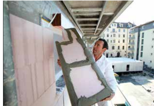
Sanierungsarbeiten: Wärmedämmung an einem Gebäude der Stadt
