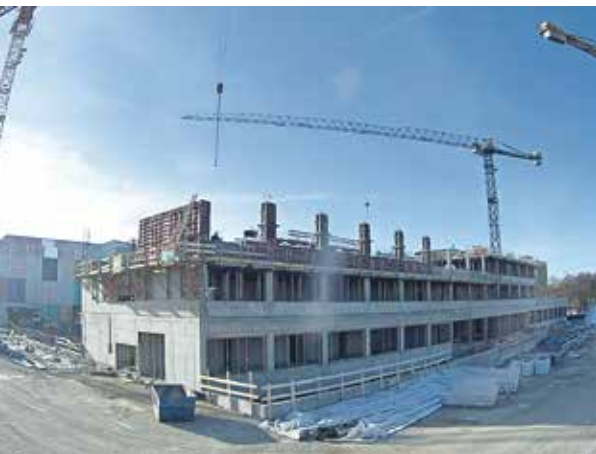
Die Bauarbeiten am Schulzentrum Nordhaide haben begonnen.
