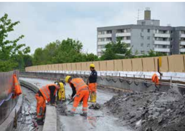
Die Gleis- und Brückenbauarbeiten an der U6 werden fortgesetzt.
