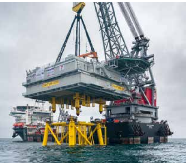
Die Arbeiten am Offshore-Windpark Dan Tysk laufen auf Hochtouren.
