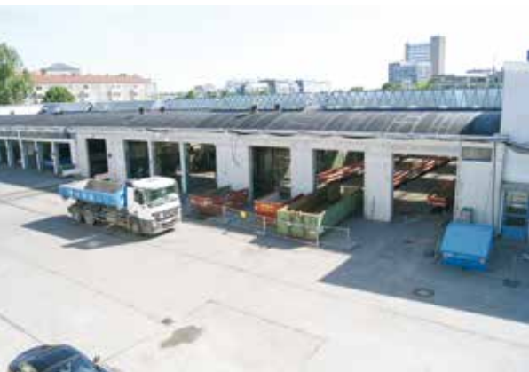
Soll generalsaniert werden: der 60 Jahre alte Busbetriebshof Ost.
