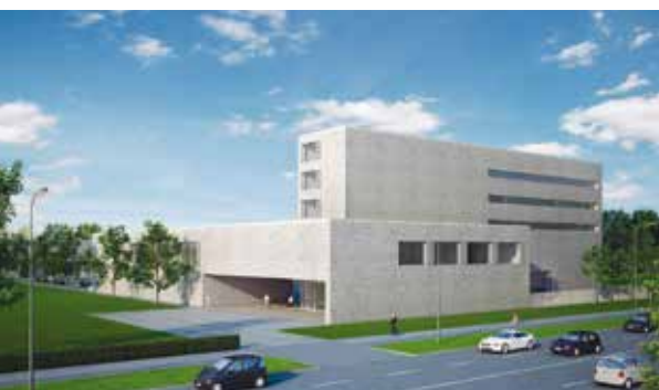
Die zentrale Kanalbetriebsstation der Münchner Stadtentwässerung soll bis Ende 2016 bezogen werden.
