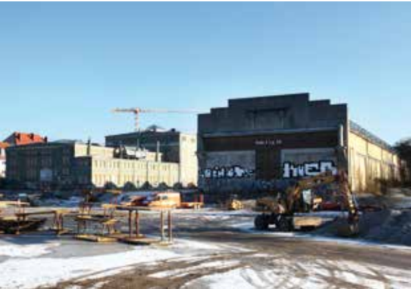
Für die Jutier- und Tonnenhalle im künftigen Kreativquartier wird an einem Nutzungskonzept gearbeitet.
