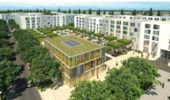
Neue Wohnungen auf dem Areal der früheren Prinz-Eugen-Kaserne
