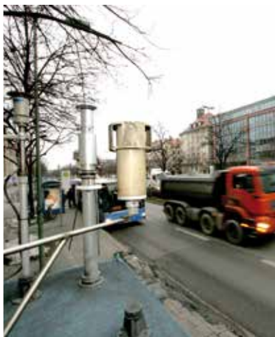
Die Messstation für Feinstaub an der Landshuter Allee
