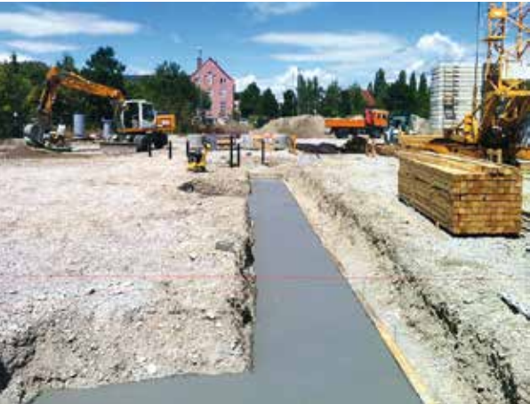
Die Baustelle der Grundschule an der Leibengerstraße
