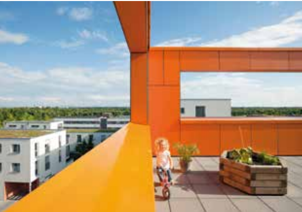
Wagnis 3 in Riem: Die Baugenossenschaft bietet modernen Wohnraum an.
