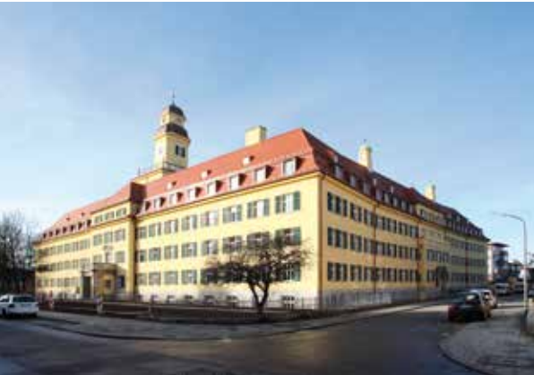
Das Münchener Bürgerheim ist grundlegend saniert worden.
