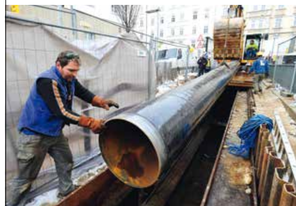
Auch die Ausbauoffensive Fernwärme der SWM schreitet voran.
