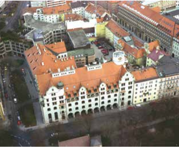
Die Hauptfeuerwache der Berufsfeuerwehr München wird saniert.
