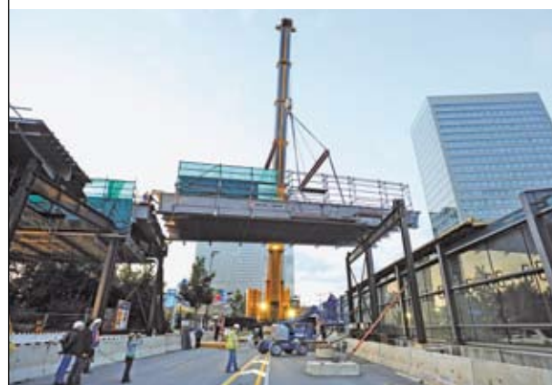
Einhub der Schrägseilbrücke über die Schenkendorfstraße
