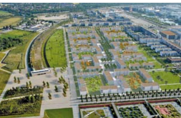
Im 4. Bauabschnitt Wohnen der Messestadt Riem sollen ca. 960 Wohnungen geschaffen werden.
