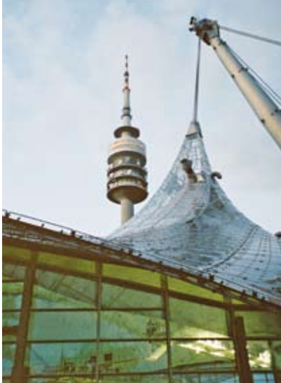
Die Olympiahalle wird umgebaut.
