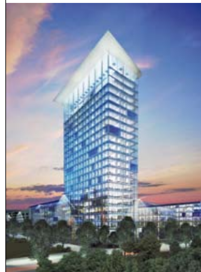
Das Ensemble des Skyline Towers wird aus einem Hochhaus und vier Campusgebäuden bestehen.
