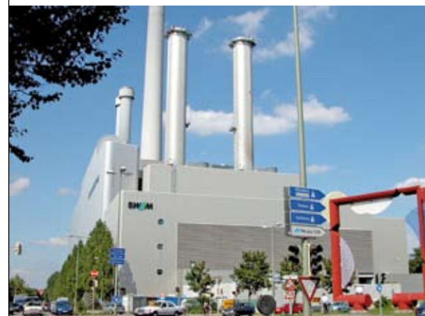
Das Heizkraftwerk Süd umfasst zwei Gas- und Dampfturbinenanlagen, die jeweils in Kraft-Wärme-Kopplung betrieben werden.
