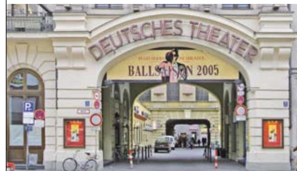
Das Deutsche Theater wird saniert.
