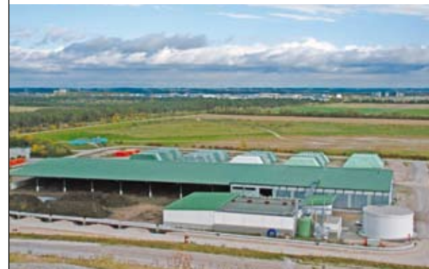
In der neuen Anlage zur Trockenvergärung werden 25.000 Tonnen Bioabfälle pro Jahr verwertet.
