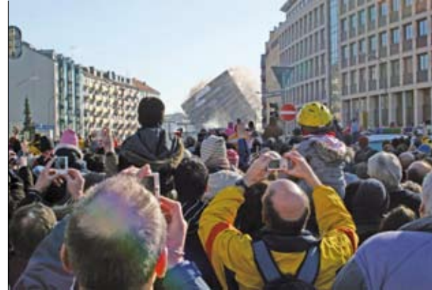
15.000 Zuschauer beobachteten, wie das Agfa-Hochhaus in sich zusammenfiel.
