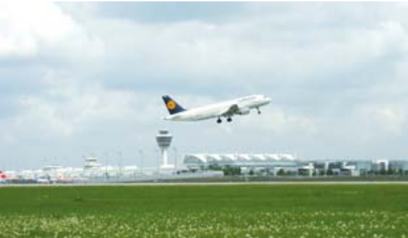
Das Planfeststellungsverfahren zum Bau einer dritten Start- und Landebahn wird voraussichtlich im Herbst 2010 abgeschlossen.
