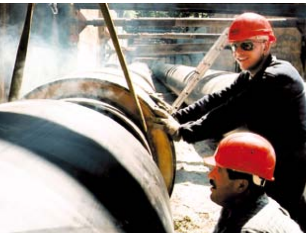
Die SWM erweitern ihr Fernwärmenetz.
