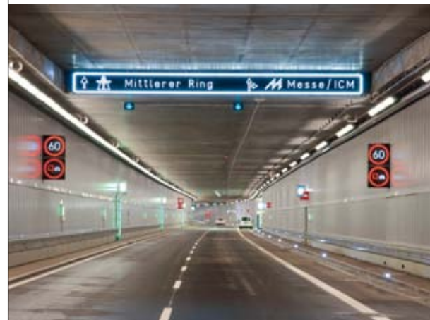
Der Richard-Strauss-Tunnel ging im Juli 2009 in Betrieb.
