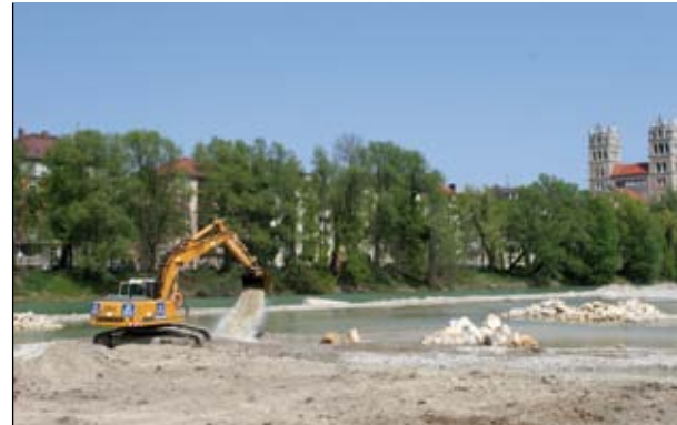
Vorletzter Bauabschnitt des „IsarPlan“-Projektes unterhalb der Wittelsbacherbrücke
