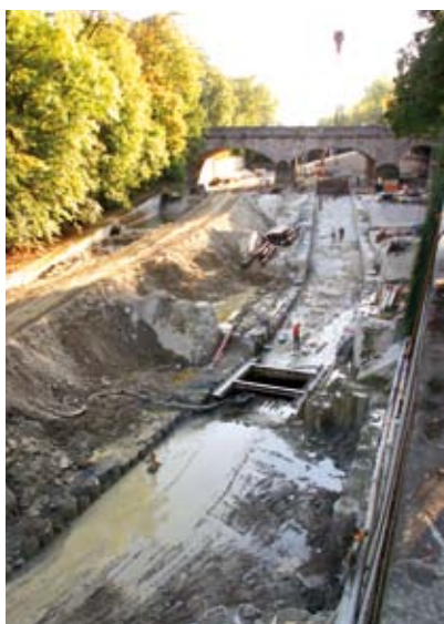
Bauarbeiten für das Praterkraftwerk
