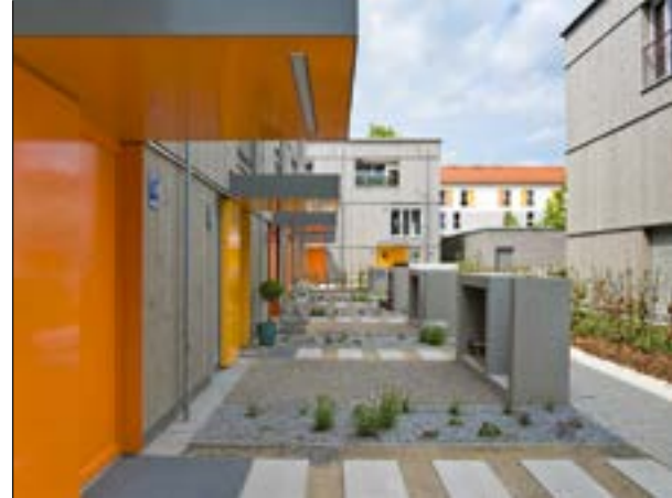
Preisgekrönte Reihenhäuser der GWG an der Dientzenhofer Straße am Harthof.
