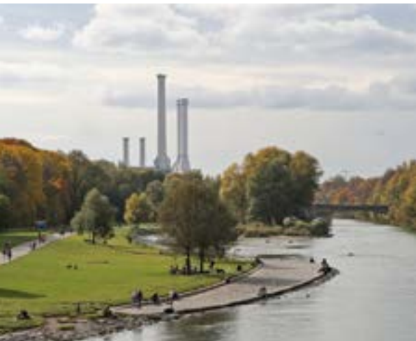
Der markante Kamin des Heizkraftwerks Süd muss weichen.
