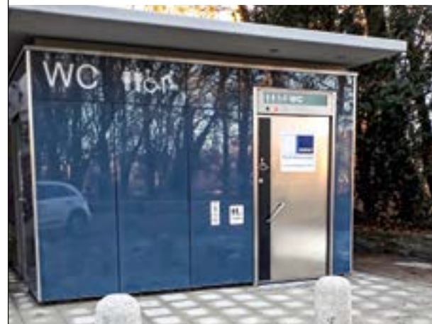
In den Frühlingsanlagen an der Isar errichtet das Baureferat eine Toilettenanlage.
