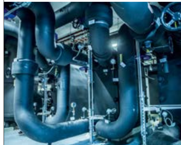
Kälte aus der Tiefe: Die SWM bauen ihr Fernkältenetz in der Innenstadt aus.
