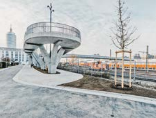
Den Weg über die Gleise ebnet die neue Fuß- und Radwegbrücke am Arnulfpark.
