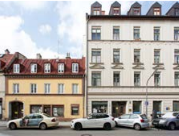
Die Tegernseer Landstraße gehört zu den Gebieten, die durch eine Erhaltungssatzung geschützt sind.
