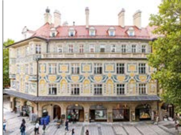
Das Ruffinihaus strahlt nach der Sanierung in neuem Glanz.
