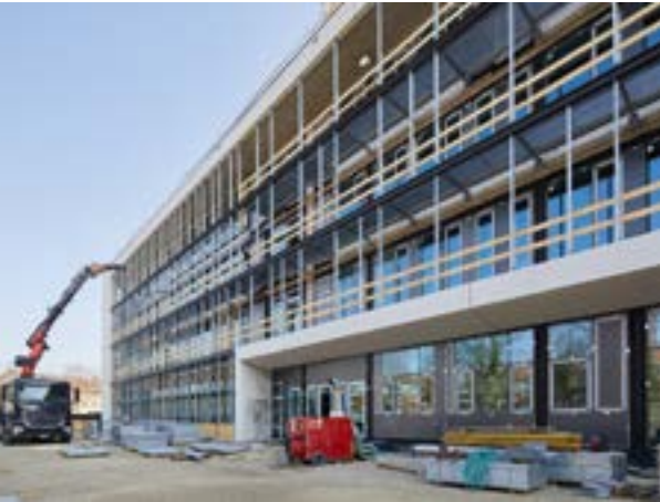
... und der Neu- und Umbau von Schulen.
