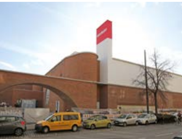
Der Rohbau des neuen Volkstheaters im Schlachthofviertel steht.
