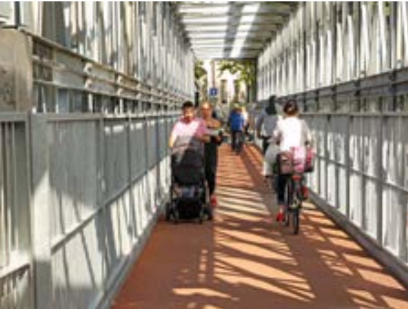
Fußgänger und Radler überqueren die Isar auf Behelfsbrücken, solange die Ludwigsbrücke instandgesetzt wird.
