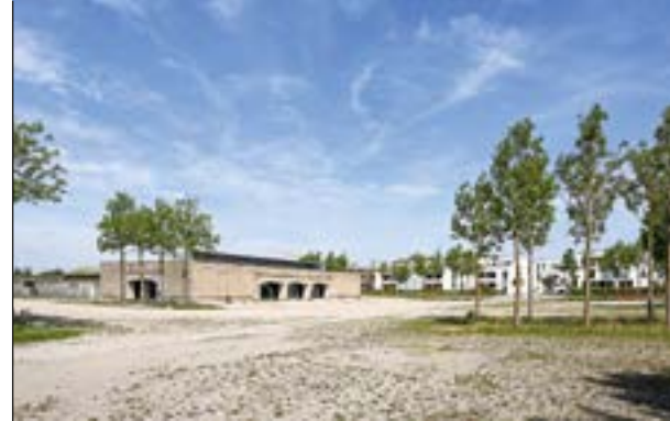
Der Kopfbau des alten Riemer Flughafens wird saniert.
