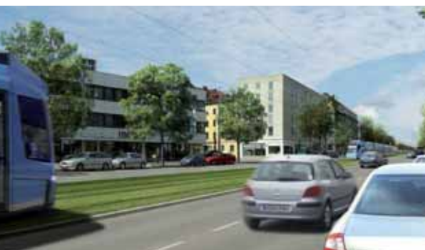
Der Bau der neuen Tramlinie zwischen Münchner Freiheit und Parkstadt Schwabing könnte 2006 beginnen, wenn das Planfeststellungsverfahren rechtzeitig beendet wird und die Finanzierungszusagen fristgerecht eintreffen.
