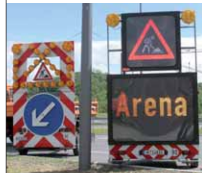
Die unter extremem Termindruck stehenden Maßnahmen zur Herstellung der öffentlichen Infrastruktur für die neue Fußball-Arena in Fröttmaning können rechtzeitig fertiggestellt werden.
