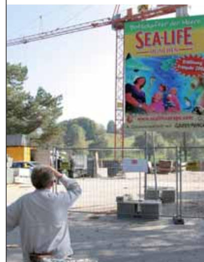
Das Sea Life Centre entsteht am Ufer des Olympiasees.
