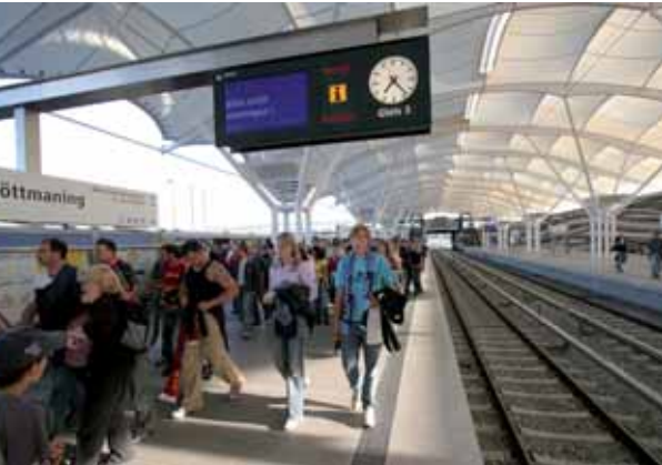
Der U-Bahnhof „Fröttmaning“ ist von einem auf zwei Bahnsteige mit vier statt bisher zwei Gleisen erweitert worden.
