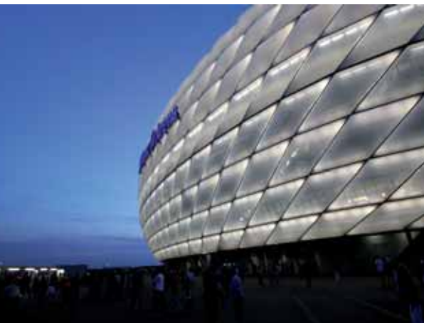
Die Arena ist mit einer glatten Außenhaut aus Kunststoff überzogen, die Umhüllung ist lichtdurchlässig und kann je nach Ereignis unterschiedlich beleuchtet werden.
