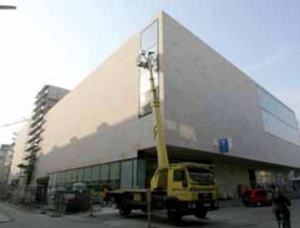
Erweiterungsbau des Kaufhauses Karstadt-Oberpollinger auf dem Areal unmittelbar neben dem Oberpollinger-Stammhaus
