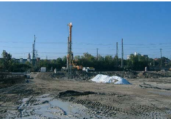
Im Juli begannen die Bauarbeiten zur Sanierung des Weyl-Geländes.
