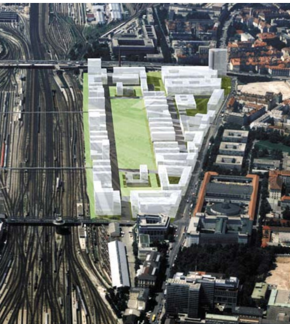
Das Gebiet „Arnulfpark“ ist eines von fünf neuen Quartieren des städtebaulichen Entwicklungsvorhabens Hauptbahnhof-Laim-Pasing.
