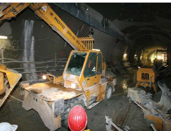
Die Bauarbeiten für zwei zusätzliche Tunnel, die die Bahnsteige im U-Bahnhof Marienplatz auf die doppelte Fläche vergrößern sollen, laufen auf Hochtouren.
