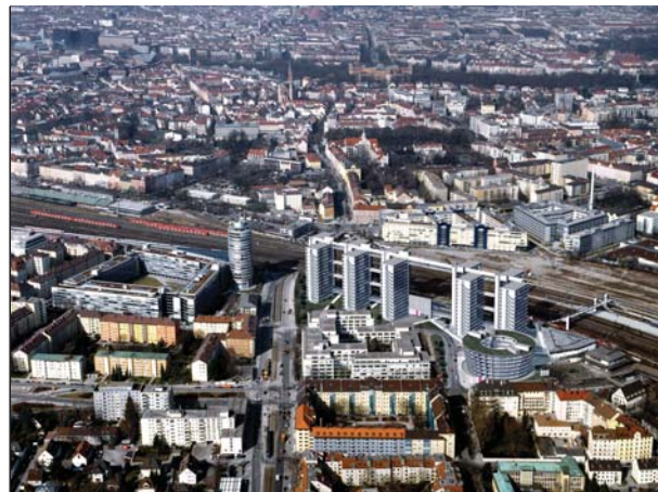
Das Telekom Center umfasst fünf Doppeltürme und einen sechsgeschossigen Rundbau.
