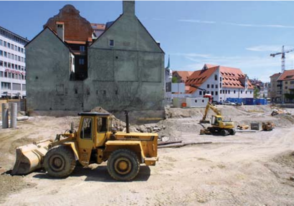
Im Juni 2004 begannen auf dem St.-Jakobs-Platz die eigentlichen Bauarbeiten.
