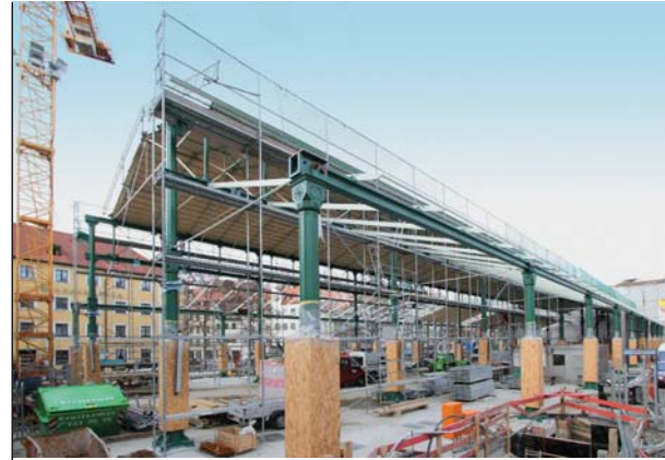
Der Wiederaufbau der Schrammehalle wird im Jahr 2005 abgeschlossen.
