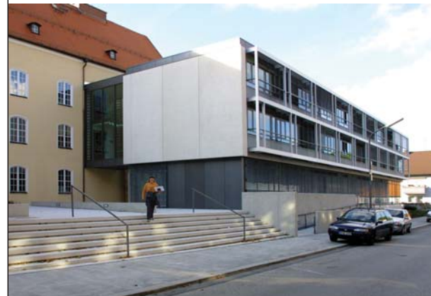
Die Groß-Bezirksinspektion West befindet sich im Bürgerzentrum Rathaus Pasing.
