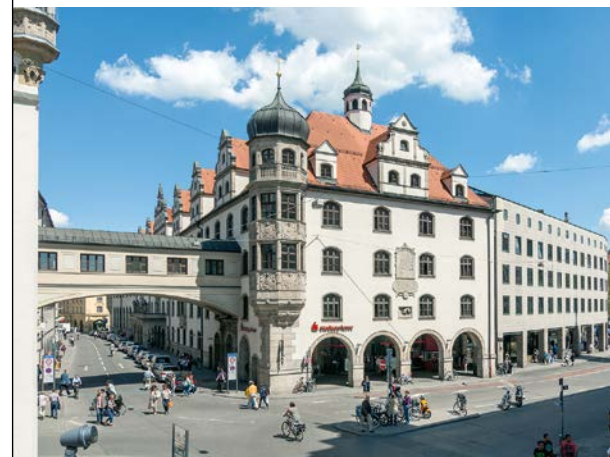
Die Zentrale der Stadtparkasse im Tal
