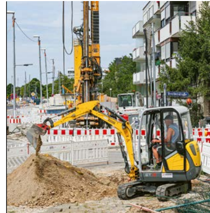
Die Bauarbeiten für den zweiten Abschnitt der Verlängerung der U-Bahn-Linie 5 starten.
