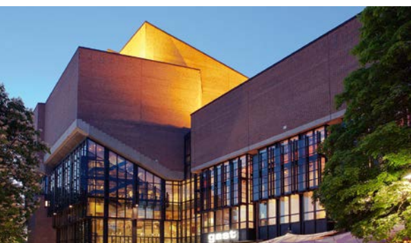
Der Gasteig soll in einem Partnering-Modell mit einem Bauunternehmen generalsaniert werden.
