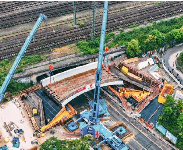
Die neue Fuß- und Radwegbrücke über die Offenbachstraße wird per Kran eingehoben.
