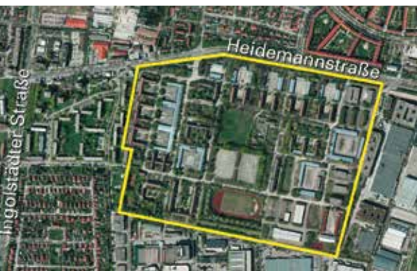
Das Gelände der ehemaligen Bayernkaserne: Hier soll ein neues Wohnquartier entstehen.
