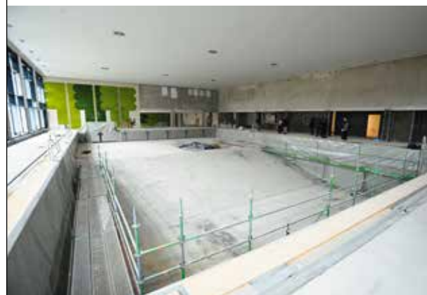
Das Hallenbad Giesing-Harlaching wird im Frühjahr wiedereröffnet.
