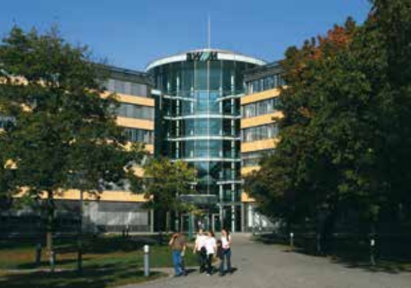
Die Zentrale der SWM an der Emmy-Noether-Straße
