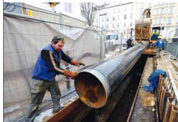
Arbeiten für den Klimaschutz: Die Stadtwerke bauen die Fernwärme aus.
