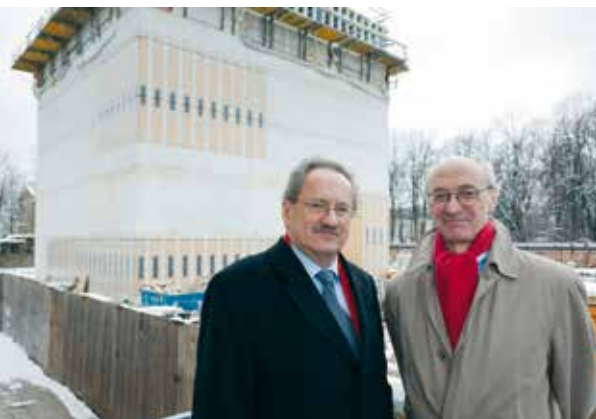
Besuch der Baustelle des NS-Dokumentationszentrums: OB Christian Ude und Gründungsdirektor Professor Dr. Ing. Winfried Nerdinger
