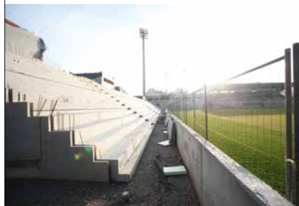
Sanierung für 10,3 Millionen Euro: das Grünwalder Stadion
