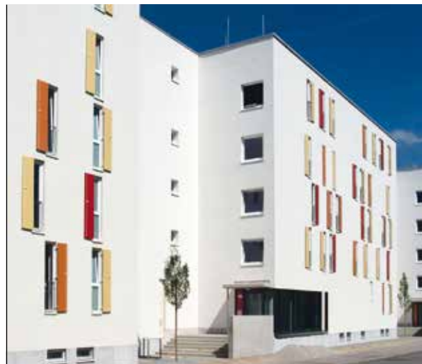
Die GWG München schließt die Großsanierung in Ramersdorf ab.
