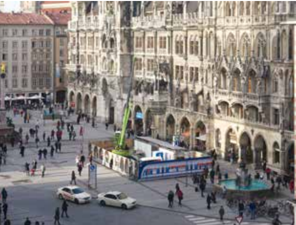
Baustelle Marienplatz: Die Arbeiten am Sperrengeschoss im Untergrund schreiten voran.
