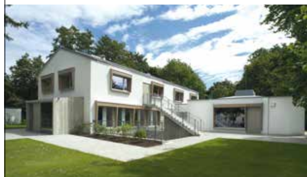
„Das Laimer“ steht nach der Generalsanierung wieder offen für die Jugend.
