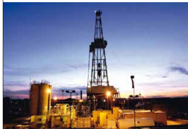
Das Geothermie-Heizkraftwerk Sauerlach
