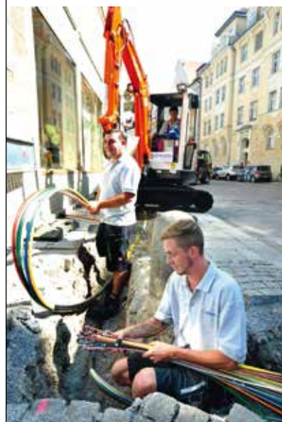
Glasfaserausbau in München: Die erste Ausbaustufe wird 2013 abgeschlossen.
