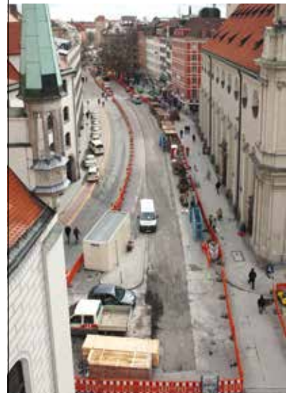
Das Tal: Die Umbauarbeiten laufen.
