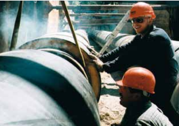
Große Investitionen: Der Ausbau der Fernwärme schreitet voran.
