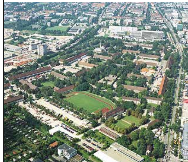
Neue Wohnungen für den Münchner Norden: die frühere Funkkaserne
