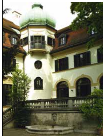
Das Literaturarchiv Monacensia soll ab 2013 saniert werden.
