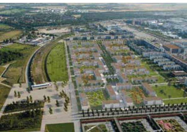
4. Bauabschnitt: In Riem werden weitere Wohnungen gebaut.
