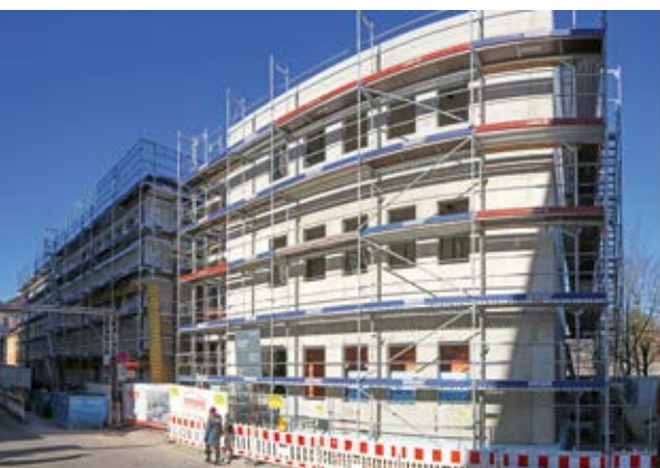
... oder die Generalinstandsetzung mit Erweiterungsbau der Kita Haimhauserstraße.
