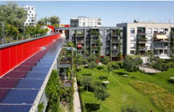
Photovoltaik auf dem Dach – das soll nach dem Klimafahrplan der Stadt künftig für alle Neubauten in München gelten.
