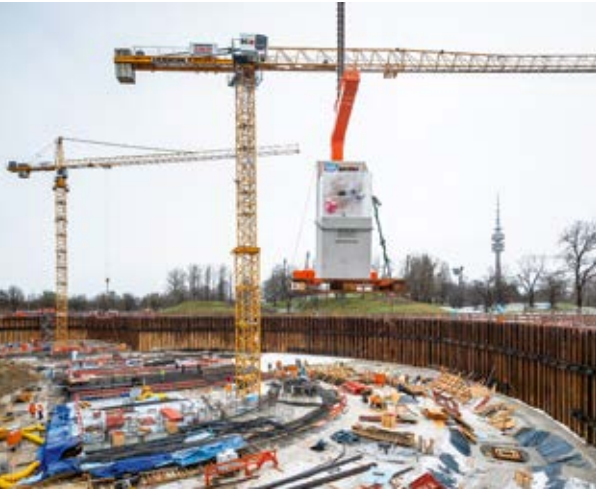
Im Olympiapark beginnen die Bauarbeiten für den SAP Garden.
