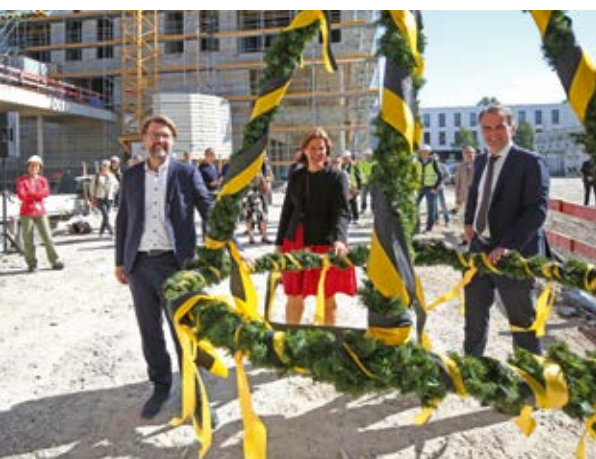
Auf Münchens größter Schulbaustelle am Bildungscampus der Messestadt Riem feiern Bürgermeisterin Verena Dietl, Stadtschulrat Florian Kraus und Kämmerer Christoph Frey Richtfest.
