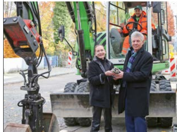
OB Dieter Reiter und Baureferentin Rosemarie Hingerl starteten bereits Ende 2019 die Spartenverlegung für die Verlängerung der U5.
