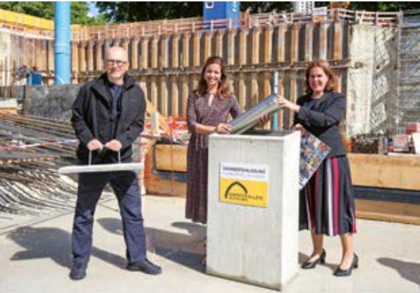
Architekt Rainer Hofmann, Kommunalreferentin Kristina Frank und Bürgermeisterin Verena Dietl legen den Grundstein für den neuen Elisabethmarkt.
