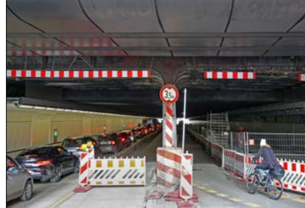
Die Paul-Heyse-Unterführung wird saniert und damit heller und freundlicher.
