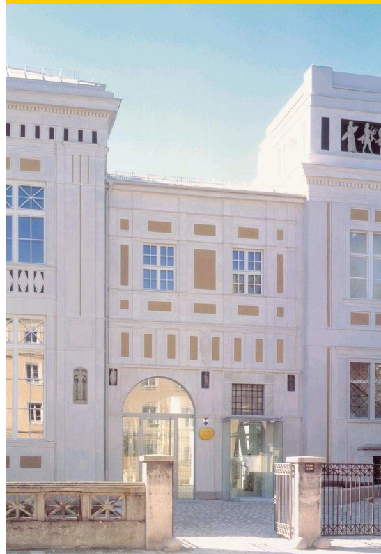
Die Restaurierungsarbeiten in der Villa Stuck kommen gut voran.
