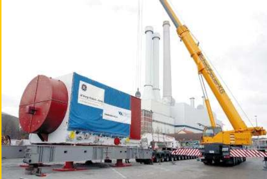
Eine der 220 Tonnen schweren Gasturbinen ist eingetroffen.
