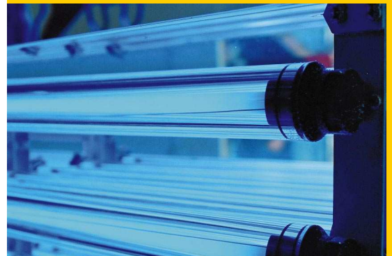
Die Ultraviolett-Desinfektionsanlage verbessert die Wasserqualität.
