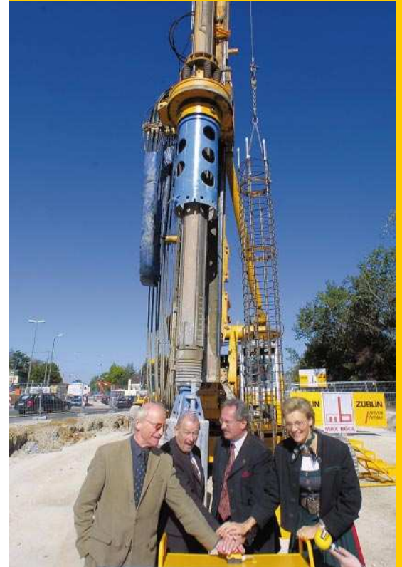
Baureferent Horst Haffner, Staatsminister Dr. Günther Beckstein, OB Christian Ude und Staatsministerin Monika Hohlmeier geben das Signal für den Baubeginn des Tunnels am Mittleren Ring Ost.
