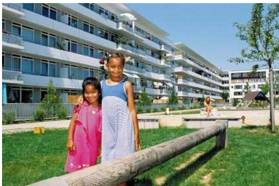
Der Wohnungsbau in der Messestadt Riem geht im Jahr 2004 kräftig voran.
