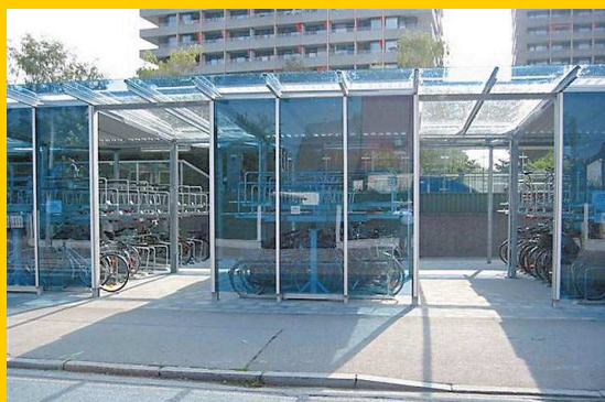
Das Radl-Parkhaus am U-Bahnhof Kieferngarten bietet 280 Stellplätze.
