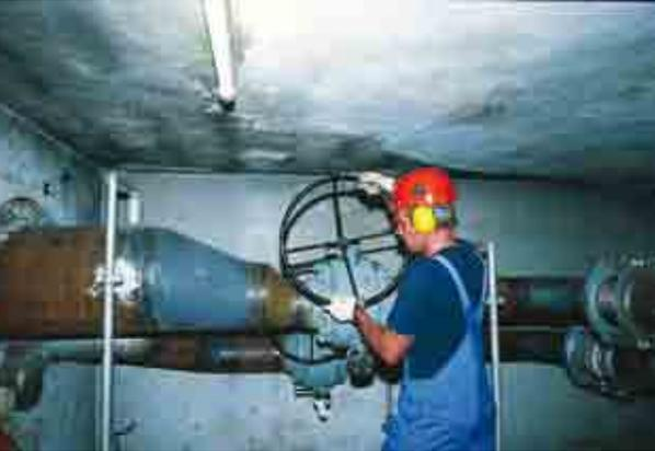
Ein Fernwärmenetzmeister in einem unterirdischen Schacht – im Bild links die alte Dampfleitung mit großem Rohrdurchmesser, rechts die neue Heißwasserleitung mit deutlich geringerem Durchmesser
