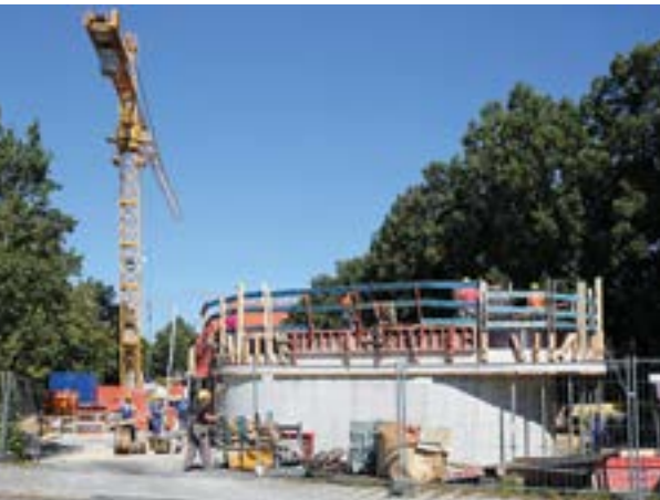
„Wohnen für Alle“: Die Arbeiten an der Homerstraße schreiten voran.
