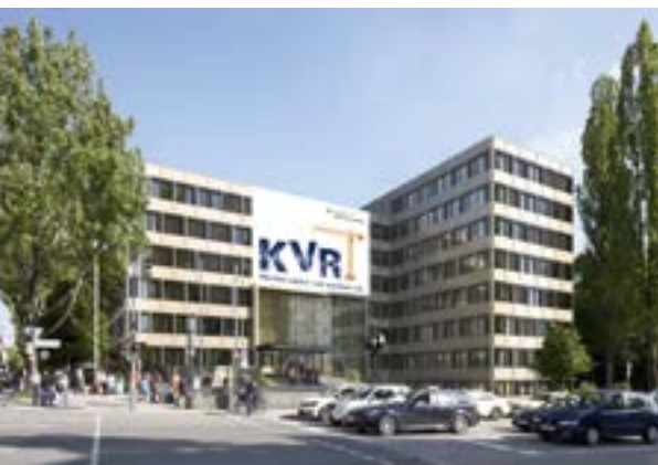
Mehr Platz für das Bürgerbüro: Das KVR wird deshalb aufgestockt.
