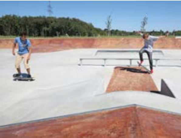
Die neue Skate-Anlage in Aubing
