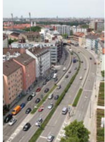
Die Tegernseer Landstraße: Auch hier wird ein Tunnelbau untersucht.
