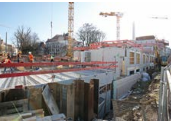
Das künftige Seniorenheim an der Grillparzer-/Einsteinstraße ist im Bau.
