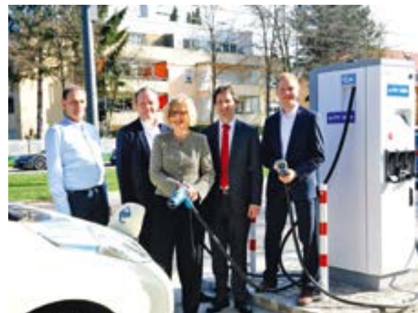
Die erste Schnellladestation von SWM/MVG wird am Arabellapark in Betrieb genommen.
