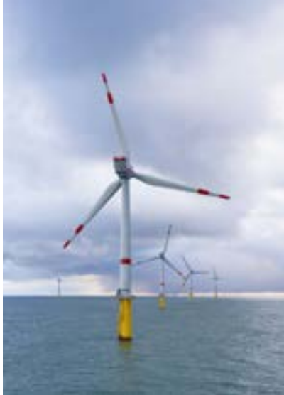
Offshore-Park Sandbank: Westlich der Insel Sylt entstehen 72 neue Windenergieanlagen.
