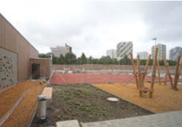
Neue Sportanlage der Grundschule an der Baierbrunner Straße
