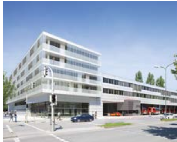
An der Anzinger Straße entsteht die neue Feuerwache 5.
