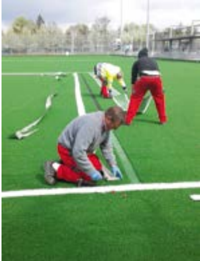
Ein neuer Kunstrasenplatz entsteht.
