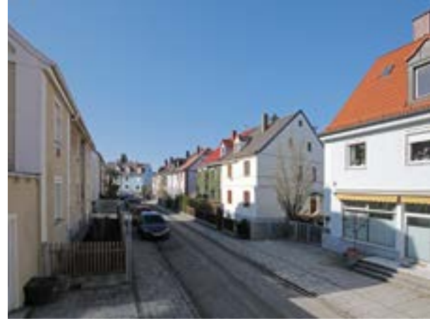
Häuserzeile im neuen Erhaltungssatzungsgebiet Sendling – Westpark
