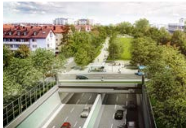
Tunnel Mittlerer Ring Südwest: Auch die Oberfläche wird nun fertiggestellt.
