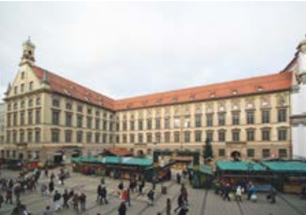
Die Alte Akademie an der Neuhauser Straße wird umgebaut.
