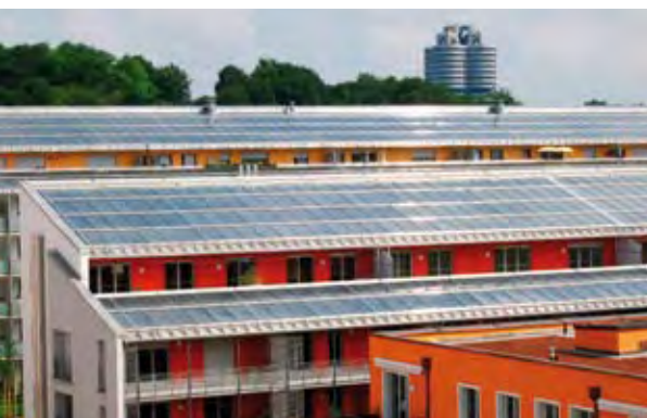
Solare Nahwärmeversorgung der Siedlung am Ackermannbogen
