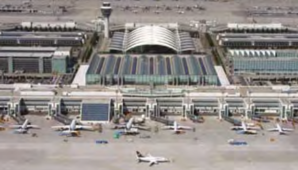
Am Flughafen wird die Realisierung der 3. Startbahn fortgeführt.
