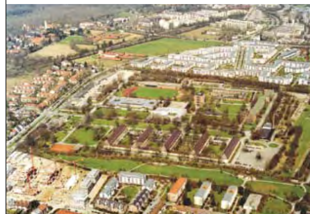
Auf dem Gelände der Prinz-Eugen-Kaserne sind 1.900 Wohnungen geplant.
