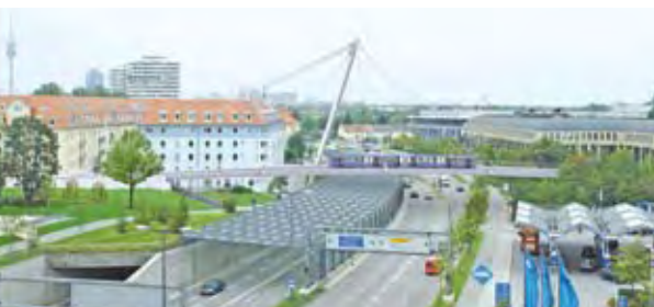
Im Zuge des Neubaus der Straßenbahnlinie 23 errichtet das Baureferat über die Schenkendorfstraße eine Geh- und Radwegbrücke in Kombination mit einer Straßenbahnbrücke.
