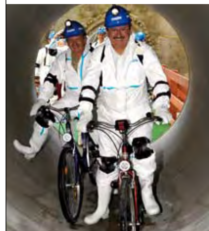
Bevor die neue Trinkwasser-Zuleitung in Betrieb geht, radelt OB Ude mit Journalisten in rund 25 Metern Tiefe durch den neuen Stollen.
