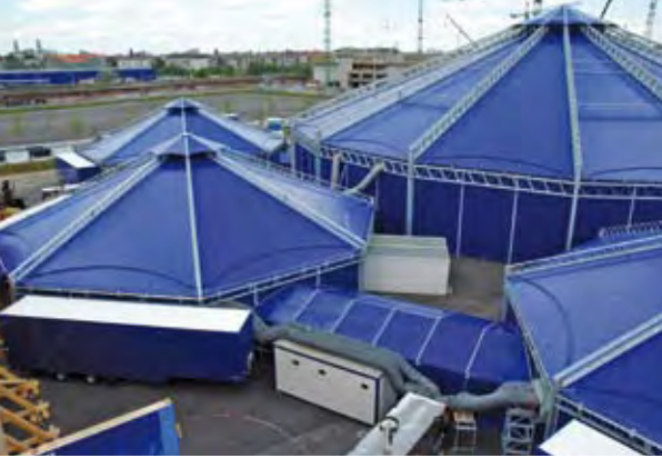
Während der Sanierung wird der Spielbetrieb des Deutschen Theaters in einer Zeltanlage weitergeführt.
