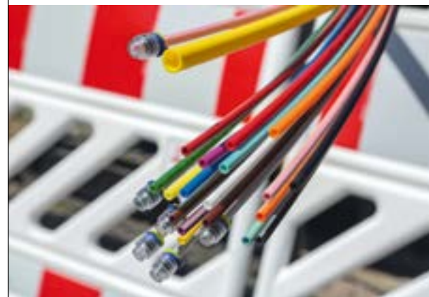
SWM und M-net setzen den Ausbau ihres Glasfasernetzes fort.
