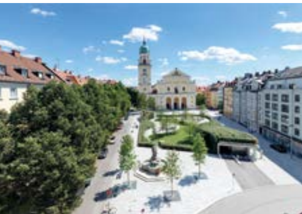
Der Josephsplatz – mit Tiefgarage und neuer Oberflächengestaltung
