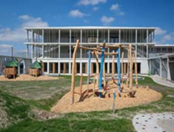
Die neue Grundschule an der Gustl-Bayrhammer-Straße in Freiham
