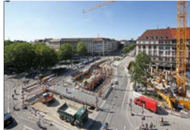
Der Umbau des U-Bahnhofs Sendlinger Tor hat begonnen.
