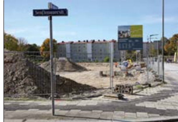
An der Ludlstraße entsteht ein weiteres Großprojekt der GEWOFAG.
